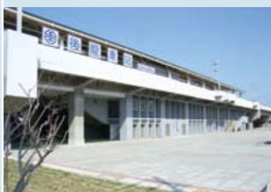
後龍高架車站
