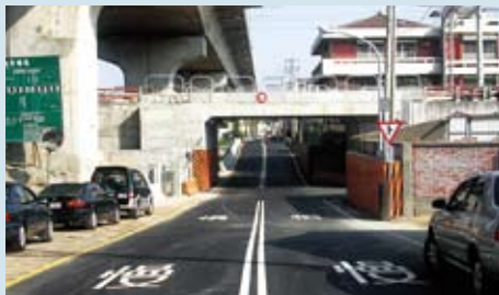
員林大排鐵路橋旁原有平交道改建為地下道
