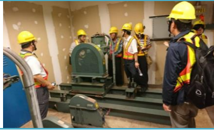
圖 3-4 板橋電梯機房
