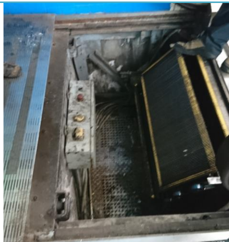
圖 3-16 花蓮電扶梯下機坑
