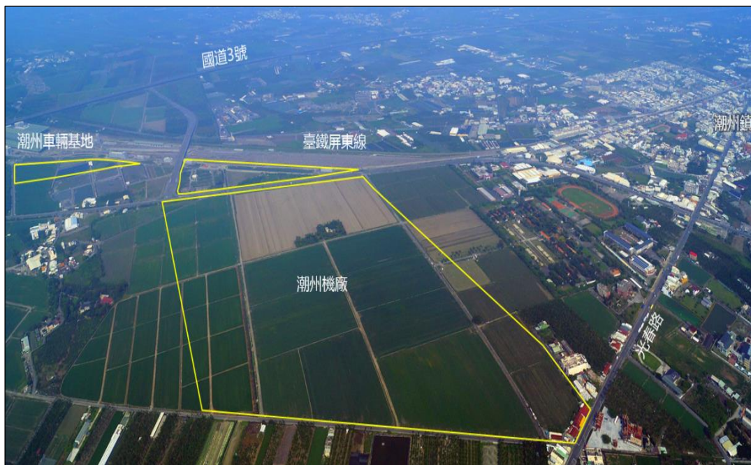
圖1.2-3 潮州機廠基地現況照片
