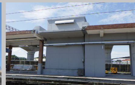
烏日站新設無障礙電梯
