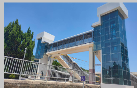
造橋站新設無障礙電梯
