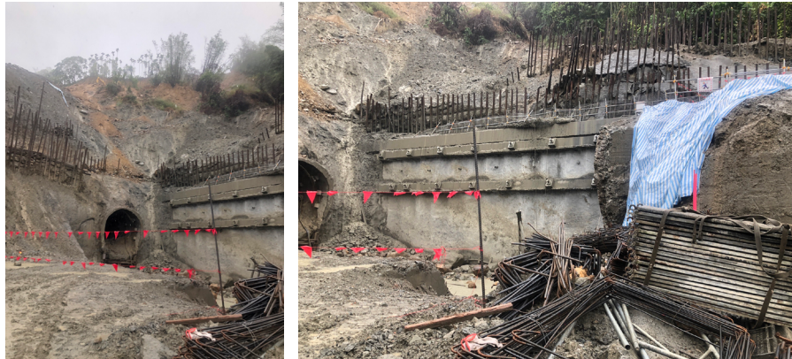
嘉義工務段—集集線新建明挖覆蓋隧道工程
