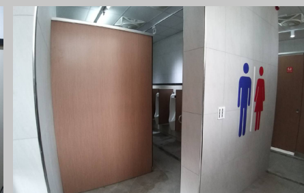
內壢站完成公廁改善
