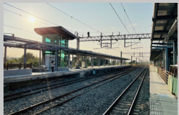
追分車站改善工程
