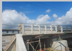
下七結橋之新設橋梁施工
