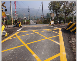
集集線及周邊各平交道改善工程
