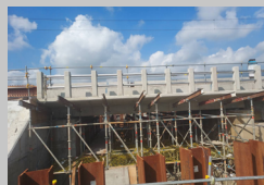
淇武蘭川橋之新設橋梁施工
