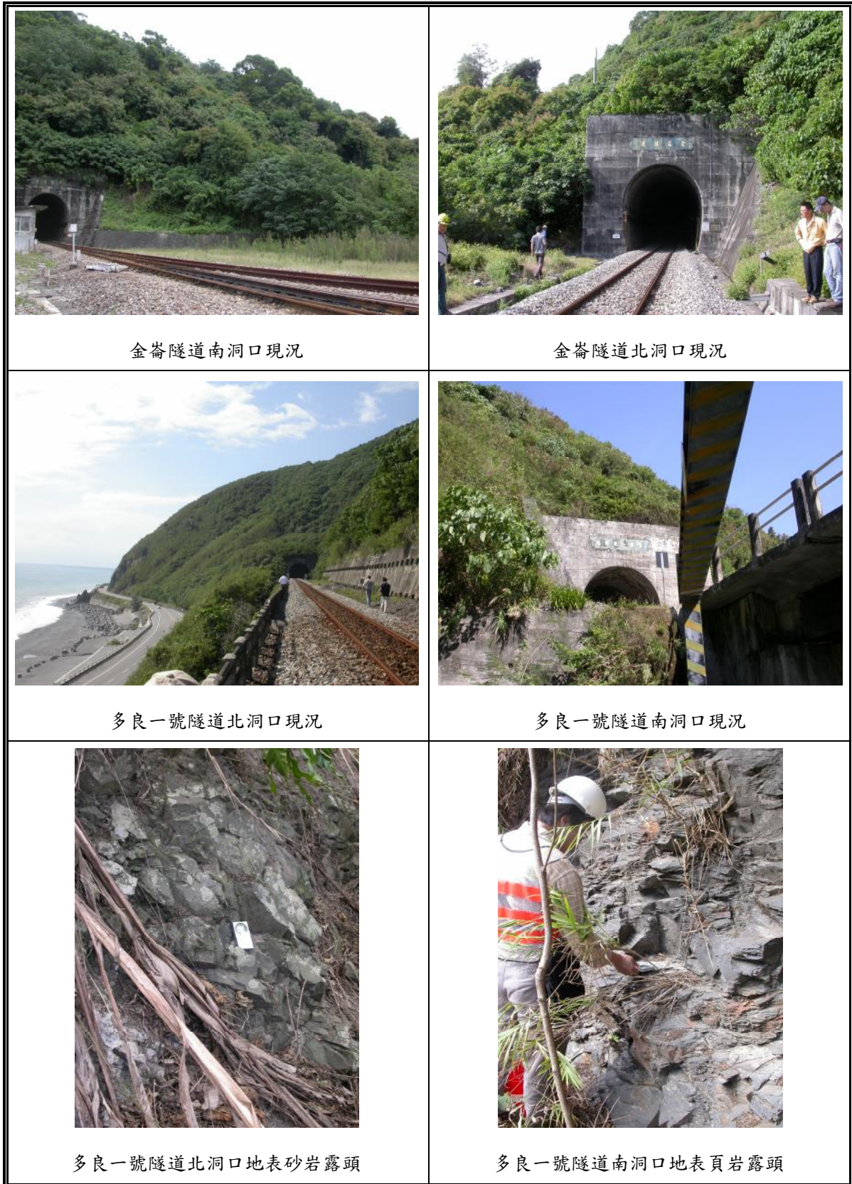
圖 3.4-1 隧道洞口現況照片 (1/4)
