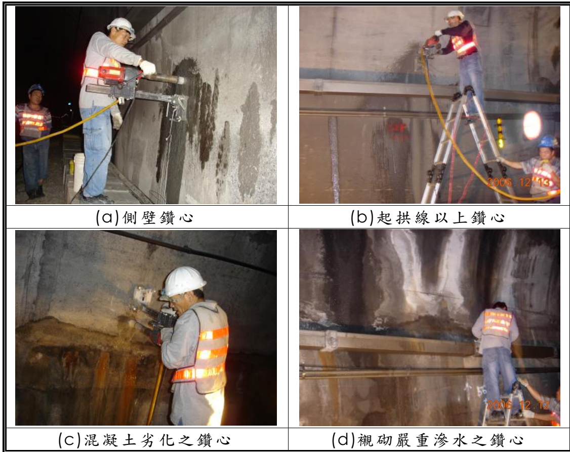
圖 3.9-1 鑽心取樣現場作業照片
