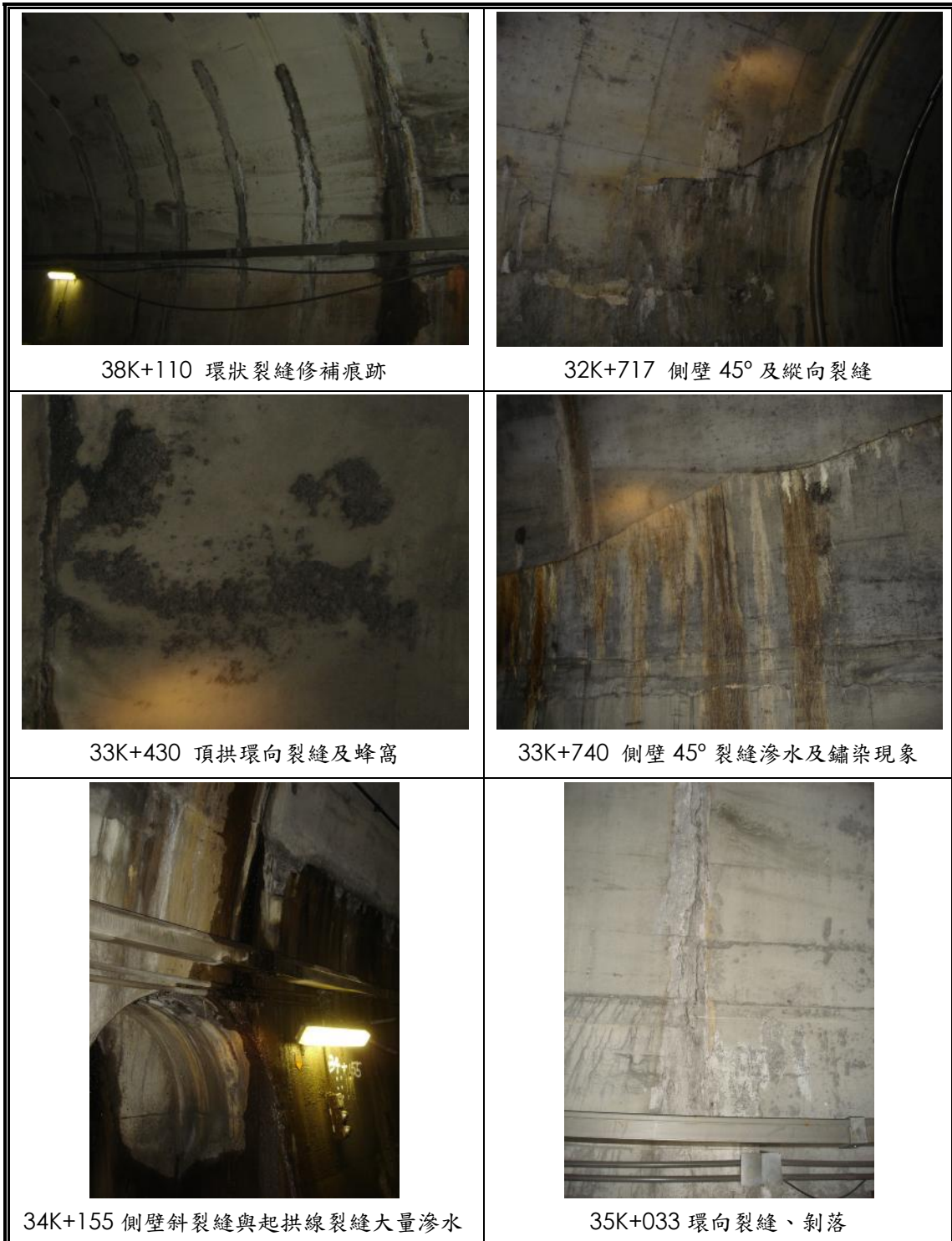
圖 3.5-13 安朔隧道內襯砌現況及說明
