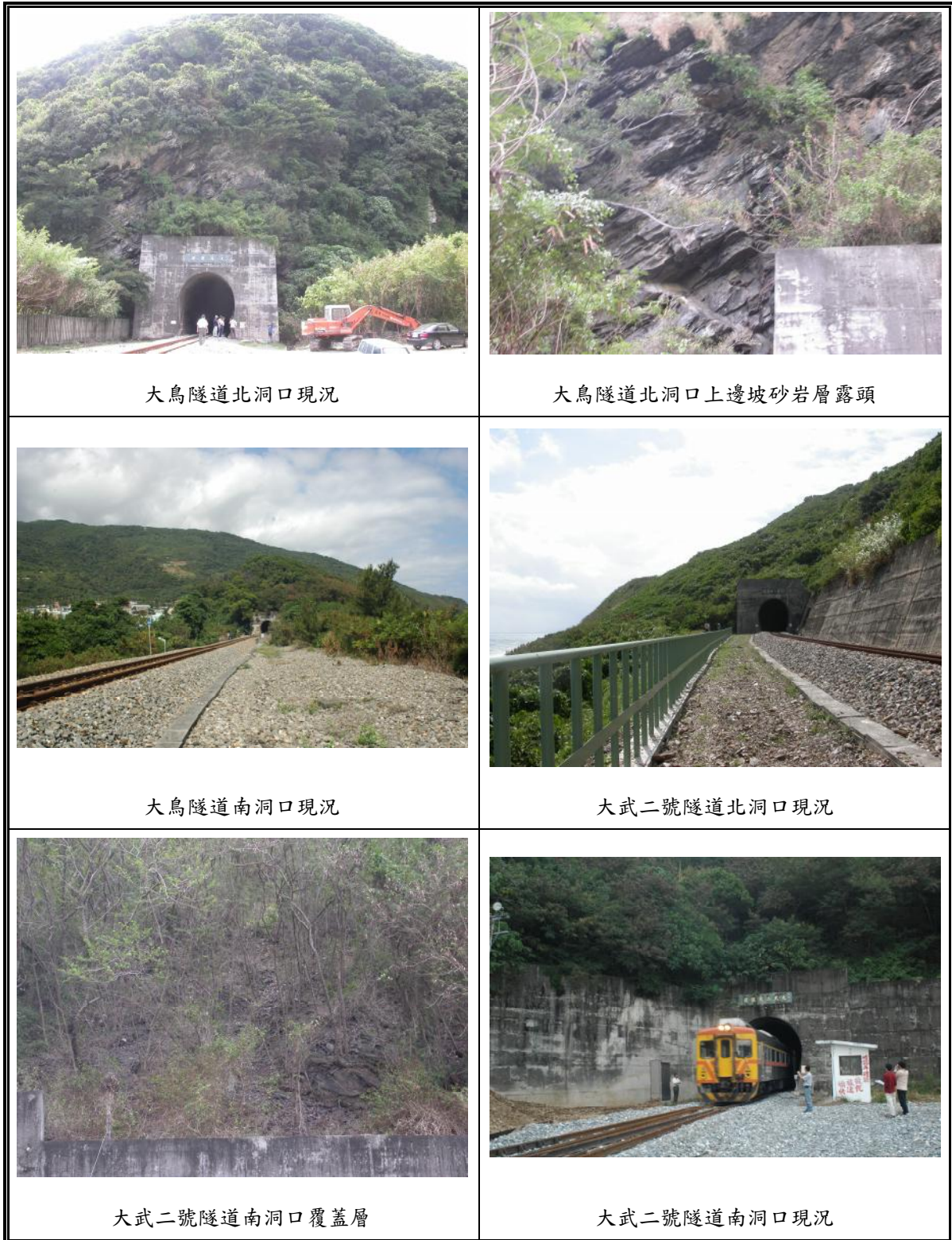
圖 3.4-1 隧道洞口現況照片 (3/4)
