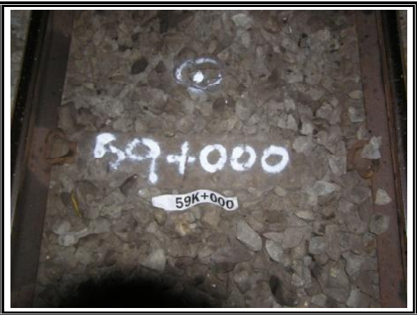
圖 3.2-2 中線測量現場標樁
