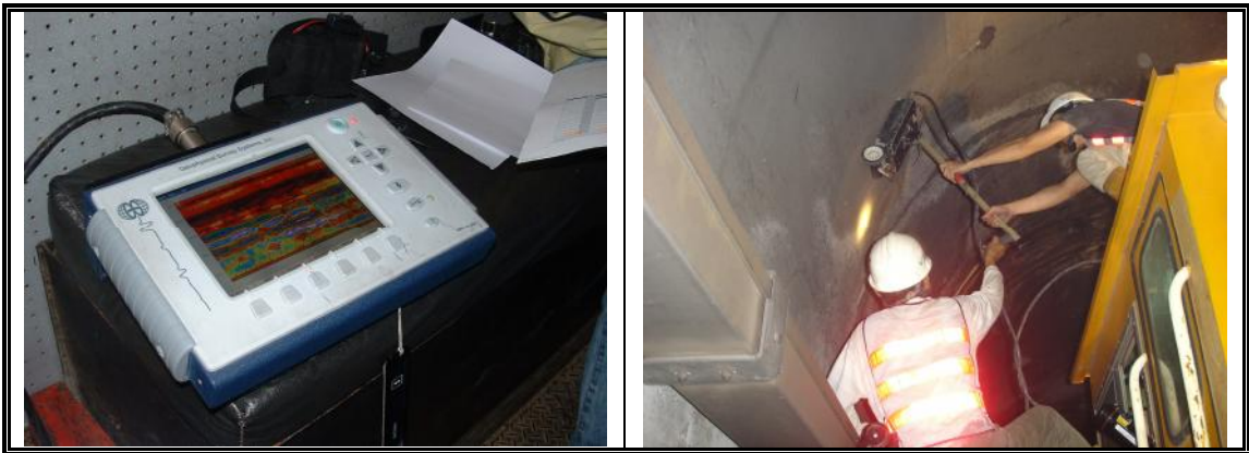
圖 3.6-1 GPR 主機及現場施測照片
