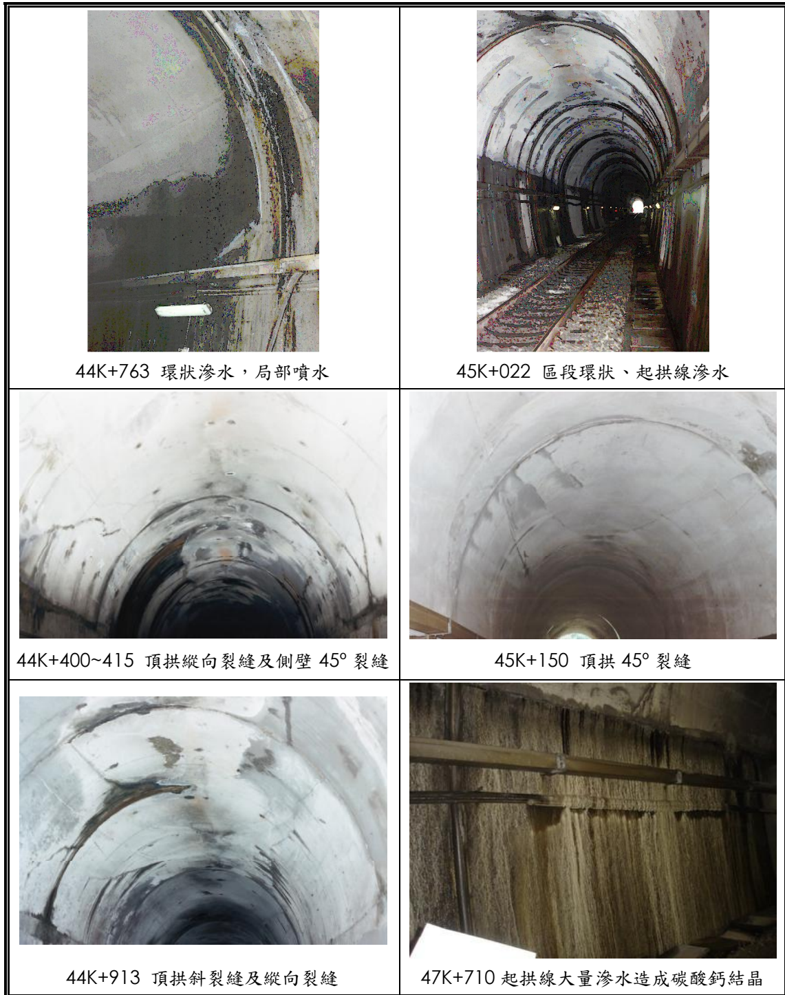
圖 3.5-12 大武二號隧道內襯砌現況及說明
