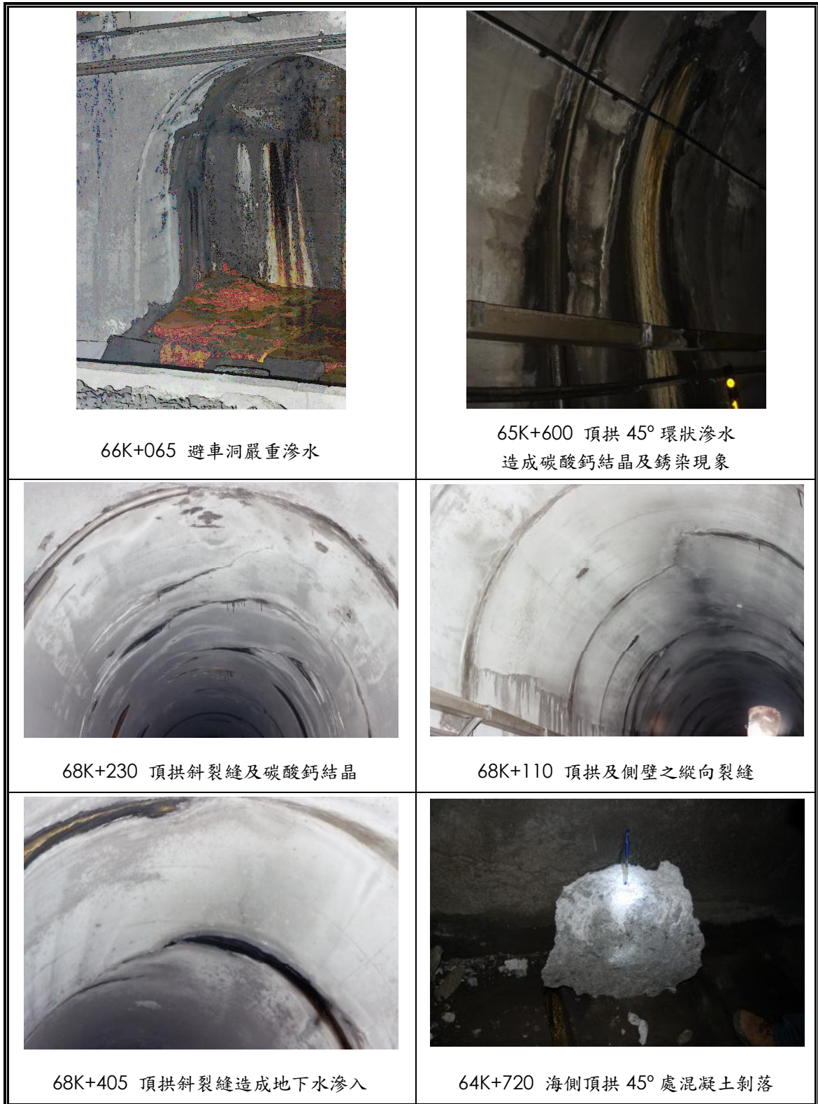
圖 3.5-6 金崙隧道內襯砌現況及說明
