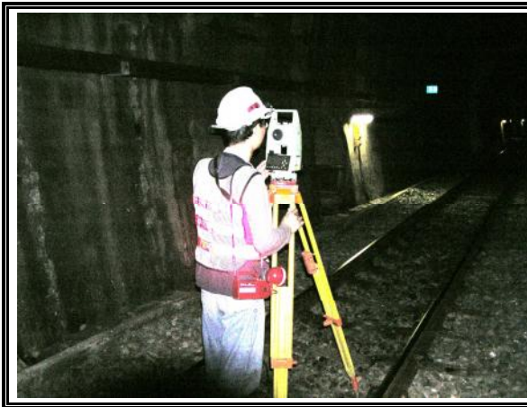
圖 3.2-1 中線測量現場作業照片
