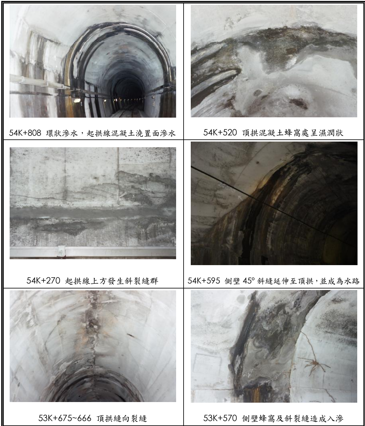
圖 3.5-10 大竹一號隧道內襯砌現況及說明
