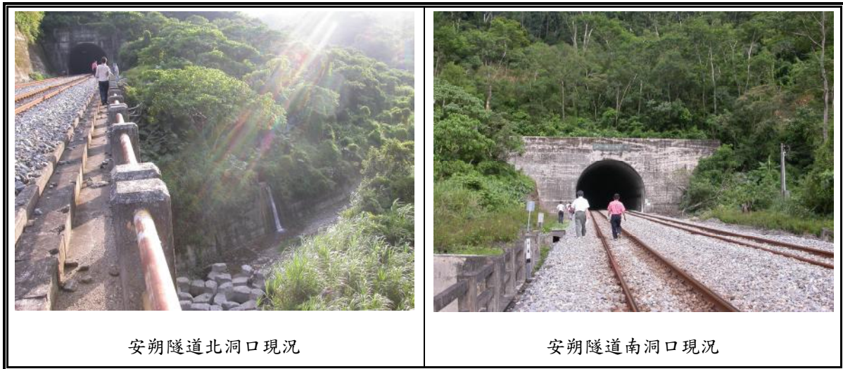
圖 3.4-1 隧道洞口現況照片 (4/4)
