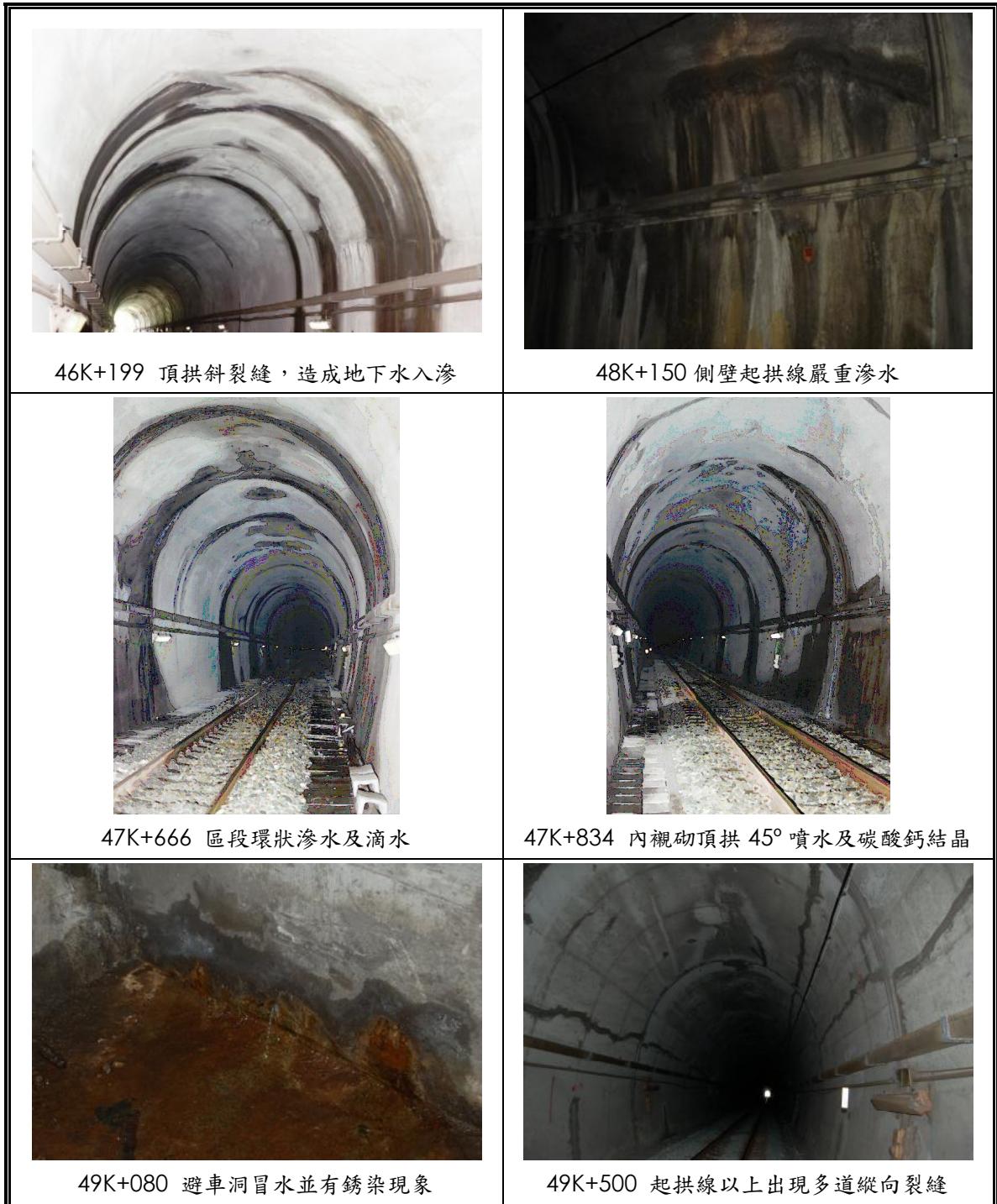
圖 3.5-11 大鳥隧道內襯砌現況及說明
