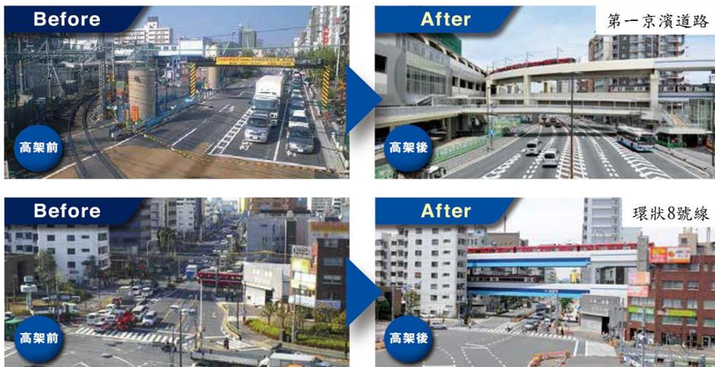
圖 9 京濱急行電鐵本線及機場線(京急蒲田站附近)連續橫交路段立體化工程周邊道路改善照片
