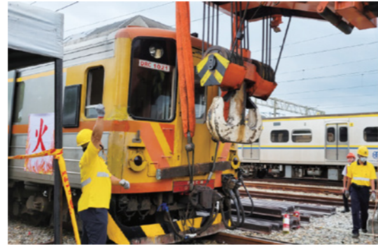
鐵安演習 - 機務搶修作業
