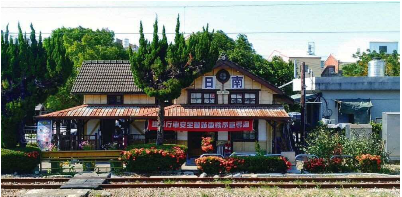
▲日式建築日南站
