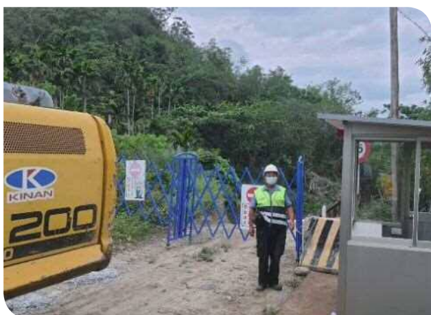
▲臨軌施工區門禁管制
