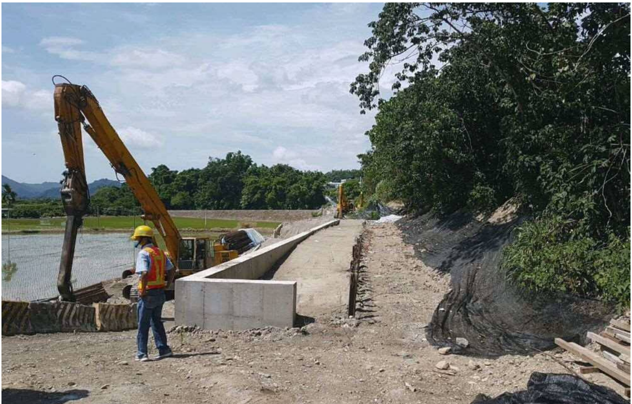
▲臺東線鹿野邊坡防護
