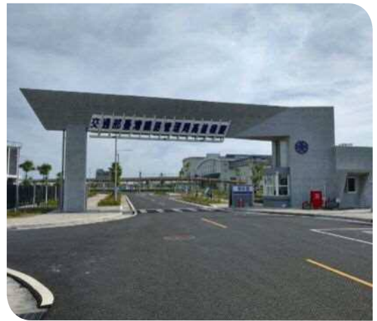
▲潮州高雄機廠出入大門
