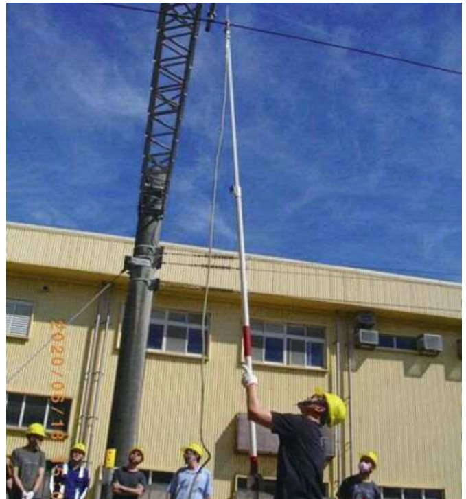
▲ 25kV 電車線下作業教育訓練
