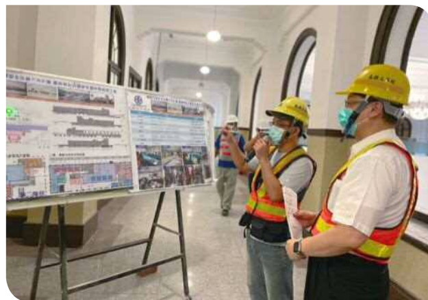
▲局長聽取台南車站古蹟維修簡報
