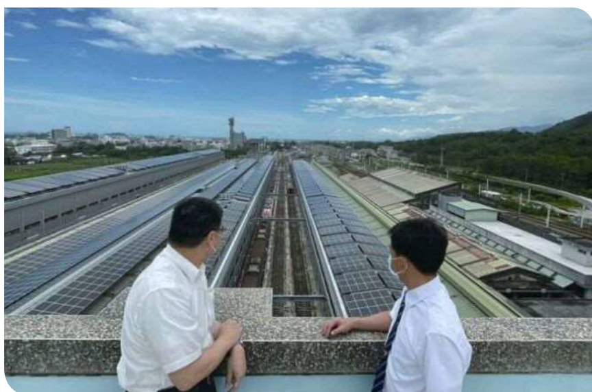
▲張志隆段長陪同局長參觀屋頂設置太陽光電板
