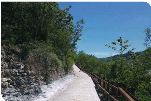
▲臺東線山里邊坡防護整治
