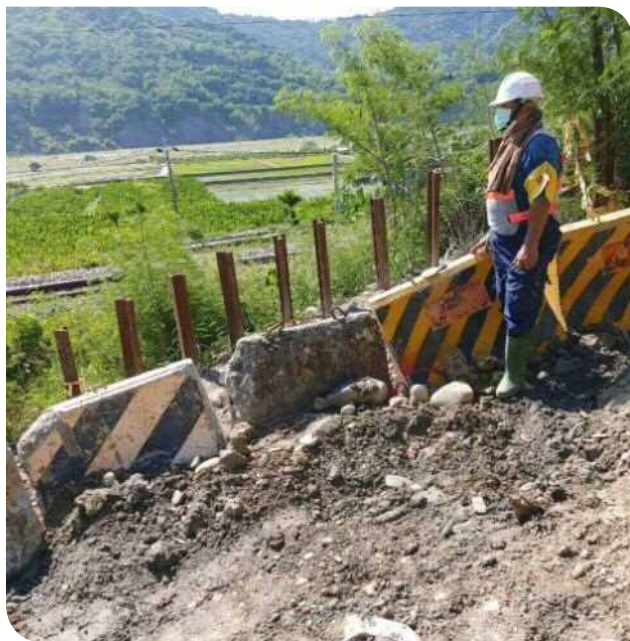
▲臺東線山里邊坡防護整治
