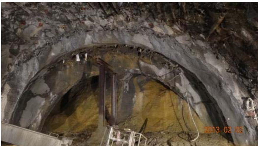
圖 5.1-3 北口 H 型鋼臨時支撐進行輔助支撐
