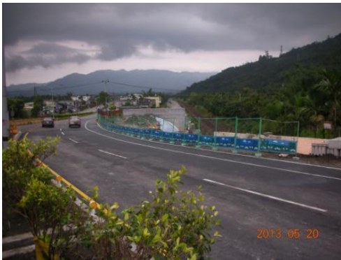
圖 16、光復隧道穿越新臺九線
