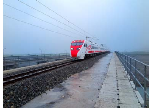
圖 11、豐坪溪橋段完成切換
