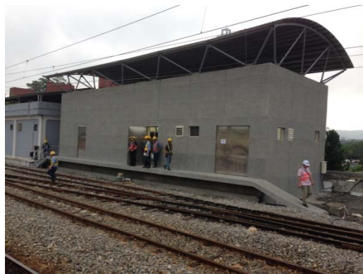
臺東站繼電器室實地勘察
