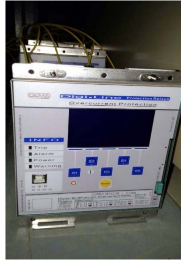
圖 6 過電流電驛
