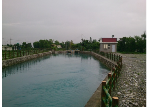
圖 15、遷建豐田圳沉砂池
