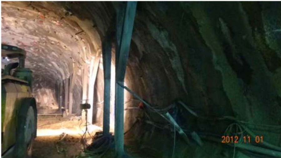
圖 5.1-2 西側受壓段架設臨時門型支撐施作實況
