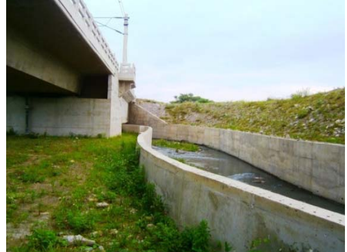
圖 9、高架橋台與排水箱涵共構
