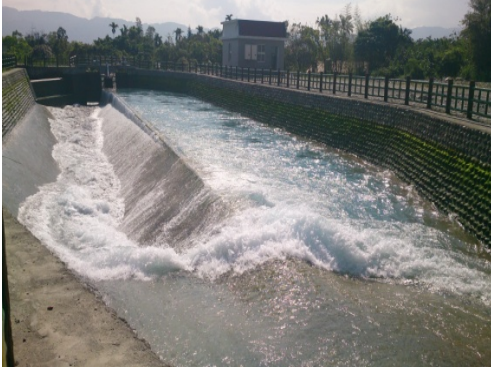
圖 8、遷建豐田圳沉砂池
