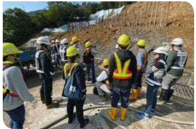
▲施工現場勘查
