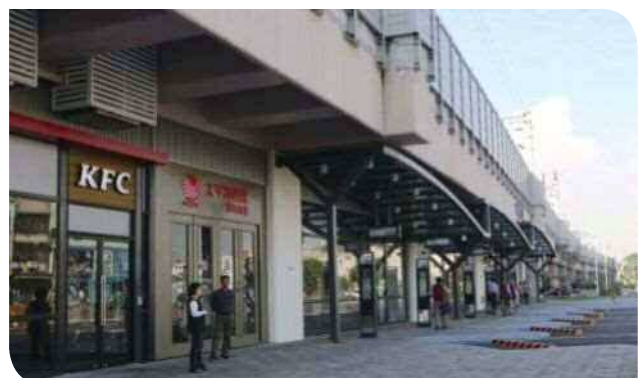
▲潮州驛站商場
