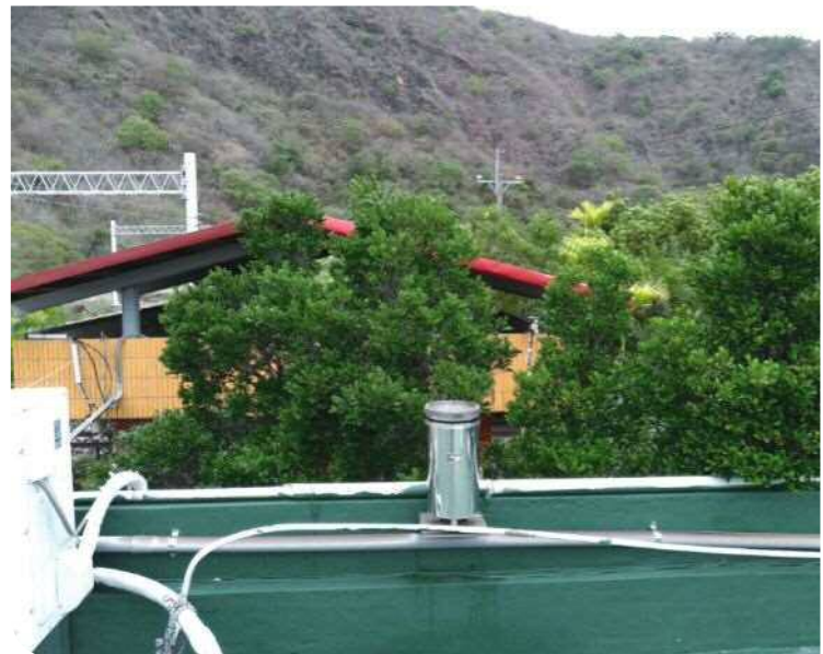
▲雨水收集筒位置
