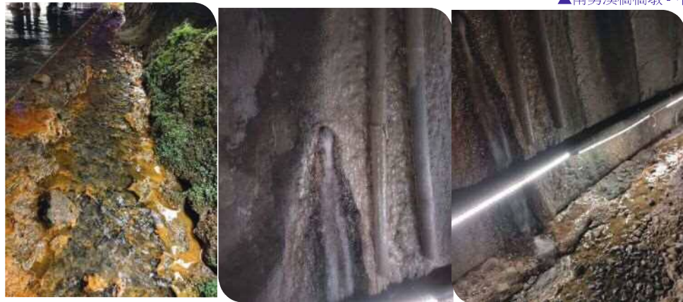
▲地底及岩壁湧出的泉水 / 由兩邊側溝截流 / 並加設照明
