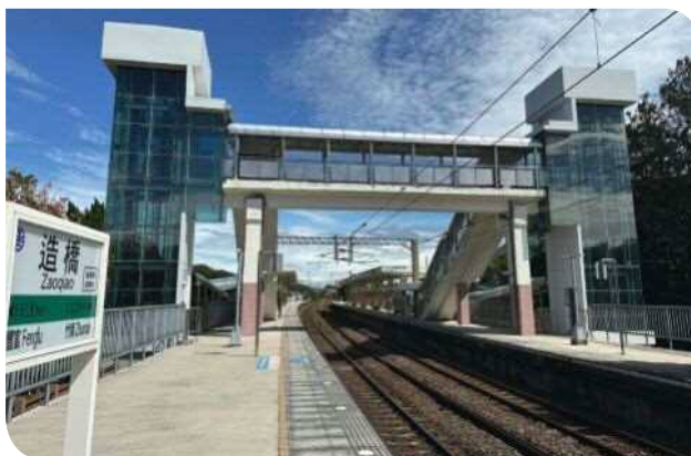
▲造橋車站無障礙電梯
