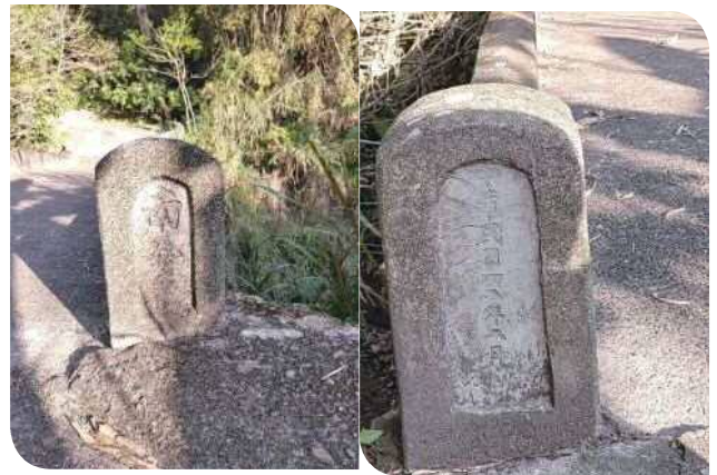
▲南勢溪橋橋墩 - 中華民國 42 年 2 月完工
