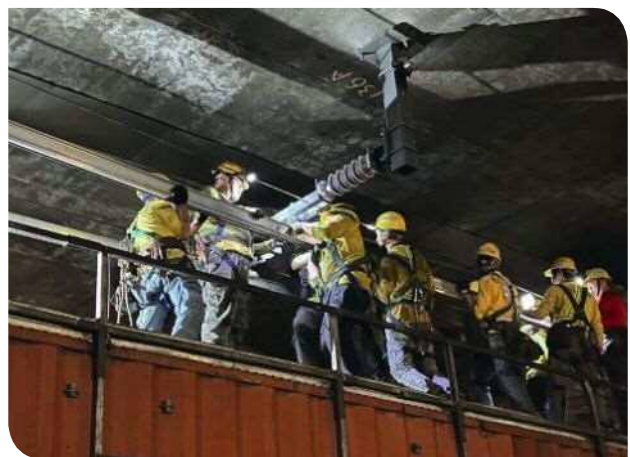
▲導電軌施工架設安裝過程
