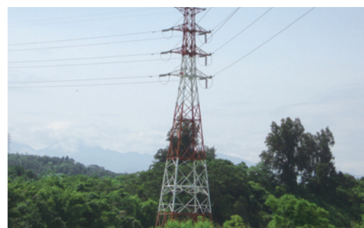
● 69KV輸電線 69KV power transmission lines
