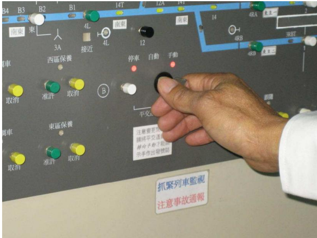
【出發號誌機故障變更閉塞方式時，受出發控制之第三種平交道應改手動控制】
