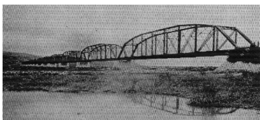
照片 6-24 完成於 1907 年之濁水溪鐵路橋
