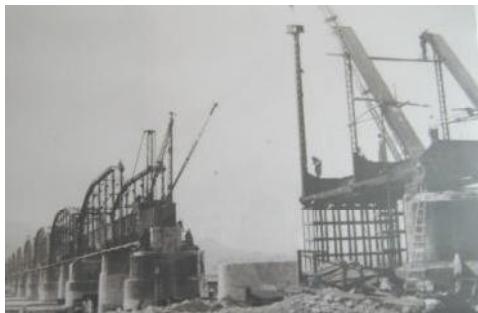
照片 7-8 大甲溪橋以臨時鋼支撐架拆解舊鋼桁架情形
