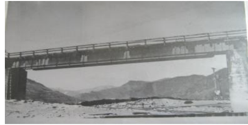
照片 8-3 東線新武呂溪橋加固後情形(1981年)
