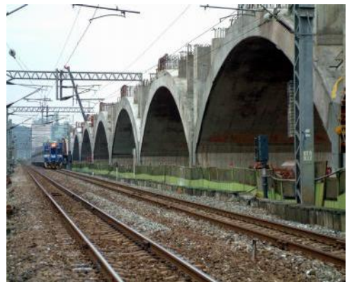
照片 9-2 多跨連續拱橋
