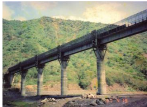
照片 8-8 設置有抗風屏之枋野二號橋
