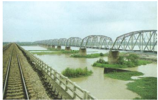
照片 6-27 於 1987 年新鐵路高屏溪橋完成、未通車前之下淡水溪橋
