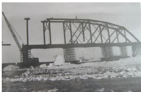
照片 7-12 濁水溪橋以臨時鋼支撐架拆解體舊鋼桁梁情形
