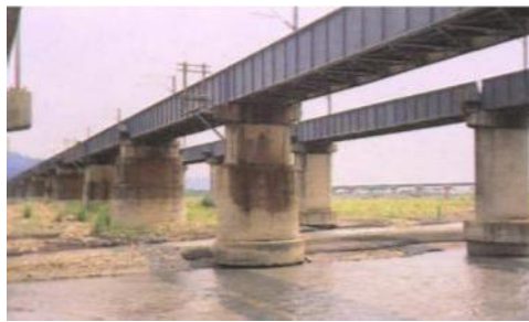
照片 7-17 雙軌後之濁水溪橋 (左邊橋梁 1927 年完成、右邊橋梁 1970 年完成)
