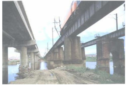
照片 6-8 第二大料炭溪橋(右為 1901 年舊橋、左為 1990 年剛完成之預力合成 U 型梁新橋)
