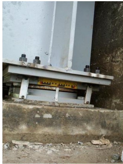
照片 4-4 盤式支承
