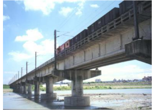
照片 8-14 1990 年頭前溪橋(預鑄預力 I 型梁)
