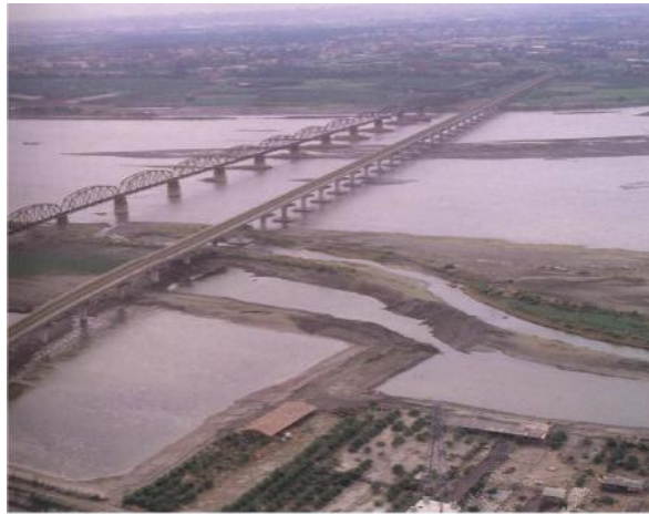
照片 8-9 新舊鐵路高屏溪橋並列
