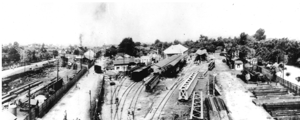
照片 7-1 鐵路局光復後在臺中設立之鋼梁廠
