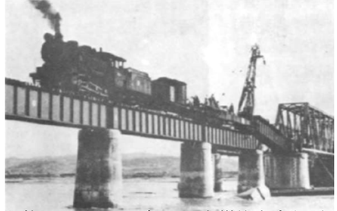
照片 7-16 1959 年八七水災後之大肚溪橋修復情形
