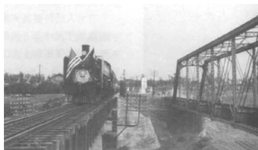
照片 7-5 第二代曾文溪橋通車典禮(左側為第二代新曾文溪鋼鈹梁橋，右側為第一代單線曾文溪鋼桁架橋)
