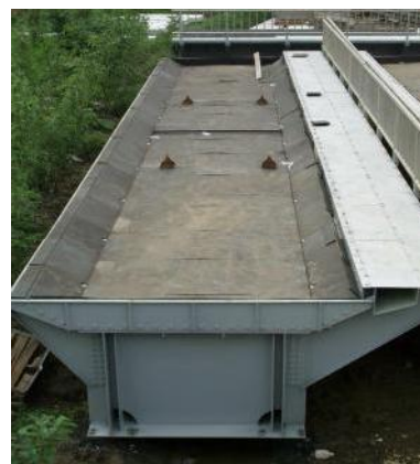
照片 3-2 箱型鋼梁
