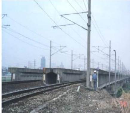
照片 8-10 1988 年第二料崁溪橋之預力 U 型梁
