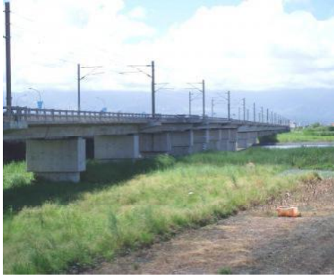
照片 9-7 濁水溪橋北端
