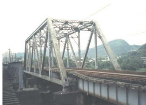
照片 6-4 1923 年縱貫線基隆河鐵路橋 (雙線鋼桁架橋)
