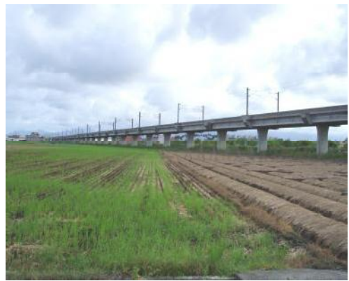
照片 9-6 濁水溪橋北端高架陸橋
