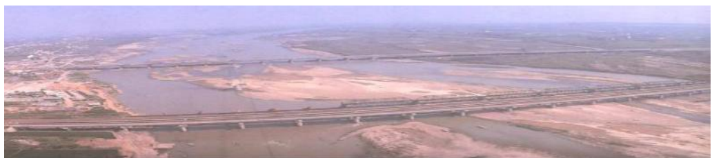
照片 6-23 大肚溪橋(中間有鋼桁架橋之路線為完成於 1924 年之鐵路大肚溪橋，另其下方是 1988 年剛完成、當時尚未使用之新大肚溪橋)
