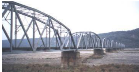
照片 6-15 完成於 1906 年之舊山線鐵路 大安溪鋼橋
