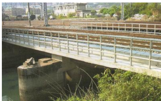
照片 9-9 改建完成之鹽田溪橋
