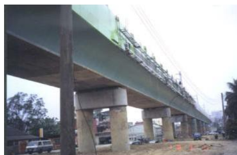
照片 8-18 苗南高架橋(1998 年)
