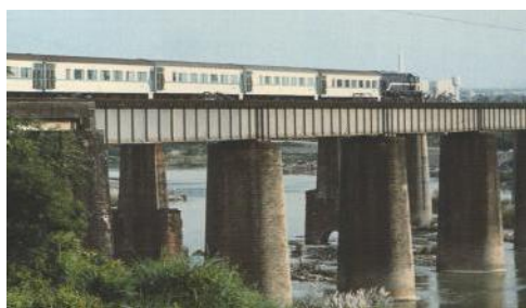
照片 7-2 更換鋼梁後之鳳山溪橋
