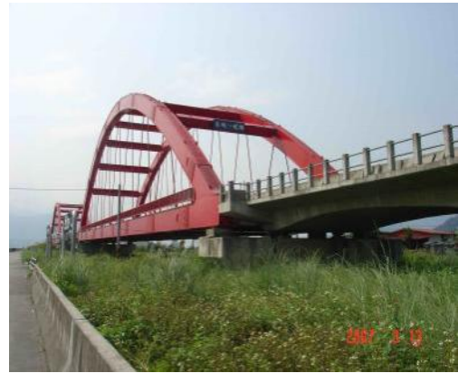
照片 9-4 塔城一號、二號鋼拱橋
