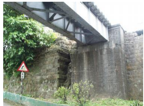
照片 3-9 舊基隆河鐵路橋混凝土橋台及兩側磚砌橋台
