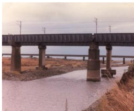
照片 6-25 完成於 1927 年濁水溪鐵路橋(近側)
