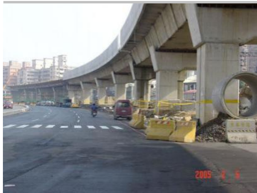
照片 9-1 預力混凝土箱型梁橋
