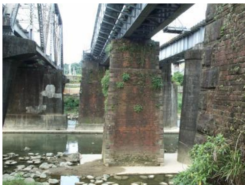
照片 3-4 八堵舊基隆河鐵路橋磚砌橋墩
