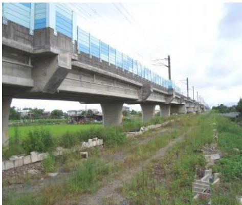
照片 9-5 濁水溪橋北端高架陸橋
