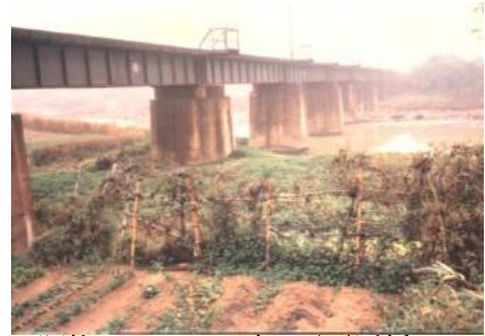
照片 6-20 1922 年 通霄溪橋
