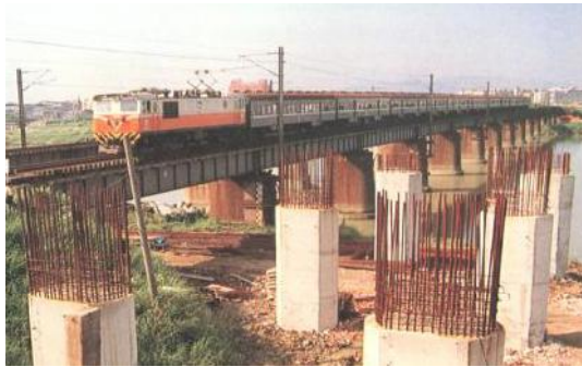
照片 6-7 1901 年新店溪橋(圖右為施工中之新橋橋墩，新橋於 1990 年完成)
