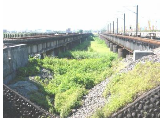
照片 8-6 宜蘭線濁水橋(右側為建於 1927 年之鋼鈹梁橋、左側為建於 1985 年之預力 I 型梁橋)
