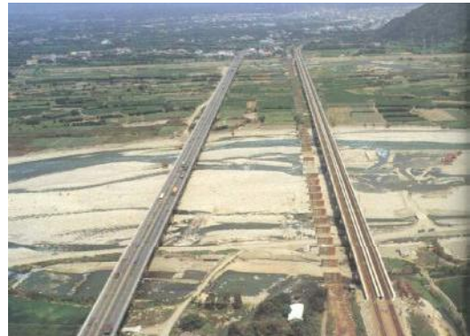
照片 8-11 最右側為 1987 年完成新下大甲溪橋，新橋左側為已拆除上部結構之舊鐵路橋
