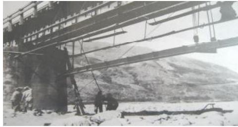
照片 8-2 東線鐵路橋加固施工情形
