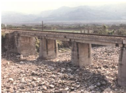
照片 8-4 改換預力梁後之成功溪橋(1981年)
