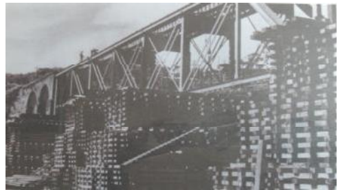
照片 6-10 縱貫線鳳山溪橋 46.9M 鋼桁架兩孔於 1950 年左右抽換工程
