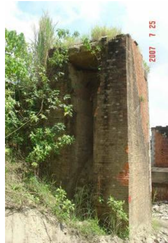
照片 3-7 臺鐵早期的磚造橋台
