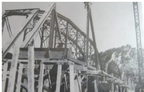
照片 7-10 大安溪橋工地組裝中之新鋼桁架梁
