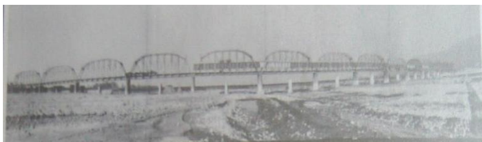
照片 7-14 濁水溪橋更換新鋼桁架梁後之全景
