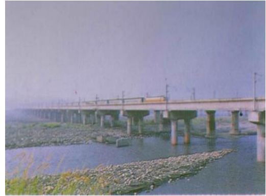
照片 8-12、8-13 濁水溪橋(預力U 型梁) 左側為 1927 年舊橋、右側 1990 年新橋
