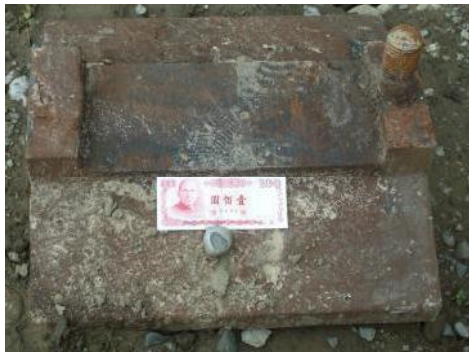
照片 4-1 台鐵舊式鋼梁支承
