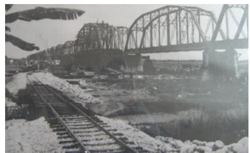
照片 7-11 下淡水溪大橋抽換新桁架梁工程
