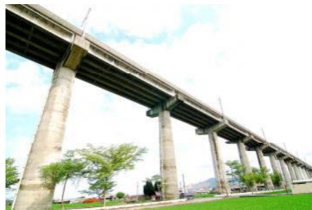
照片 8-20 泰安高架橋
