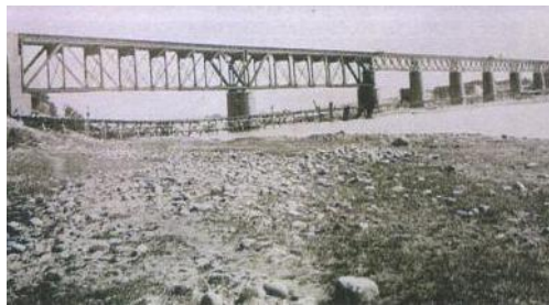
照片 6-9 完成於 1902 年之縱貫線鳳山溪橋
