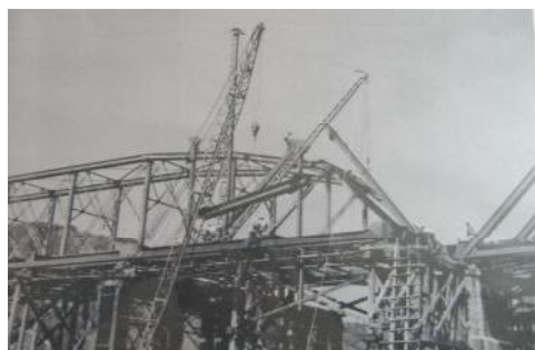
照片 7-13 濁水溪橋抽換舊鋼桁梁施工情形
