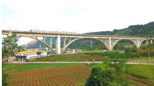
照片 8-17 鯉魚潭橋(1988 年)
