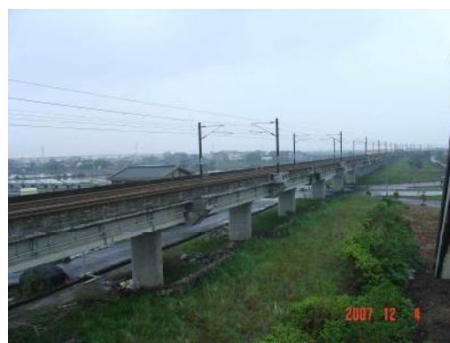
照片 3-3 I 型 RC 梁橋
