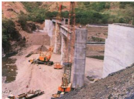
照片 8-7 施工中之枋野二號橋
