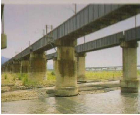
照片 8-12、8-13 濁水溪橋(預力U 型梁) 左側為 1927 年舊橋、右側 1990 年新橋
