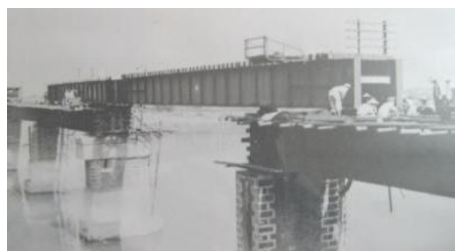
照片 7-3 新店溪橋 80 呎抽換鋼梁情形
