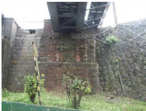
照片 3-8 舊基隆河鐵路橋磚砌橋台及翼牆
