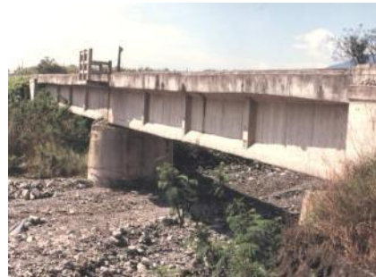
照片 8-5 改換預力梁後之水拔溪
