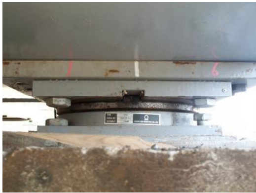
照片 4-3 盤式支承(活動端)
