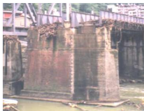
照片 6-3 基隆河鐵路橋之橋墩
