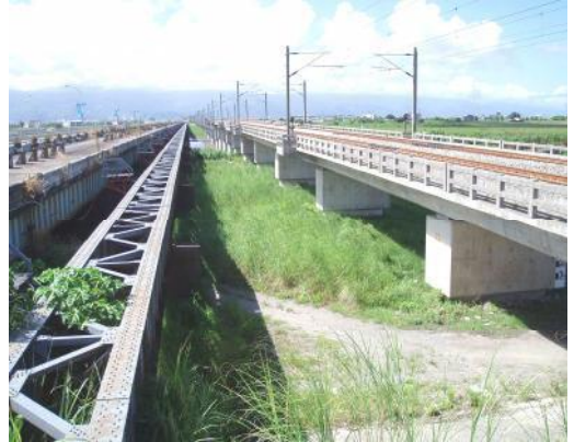
照片 9-8 濁水溪橋（左側為舊橋）
