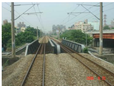
照片 3-1 槽型鋼梁橋照片示意圖
