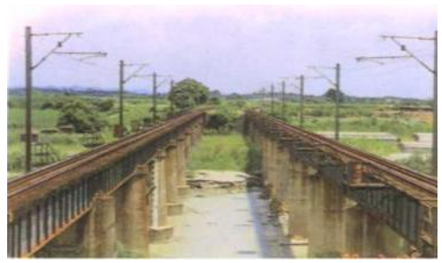
照片 7-18 雙軌後之八掌溪橋 (右邊橋梁 1905 年完成、左邊橋梁 1970 年完成)
