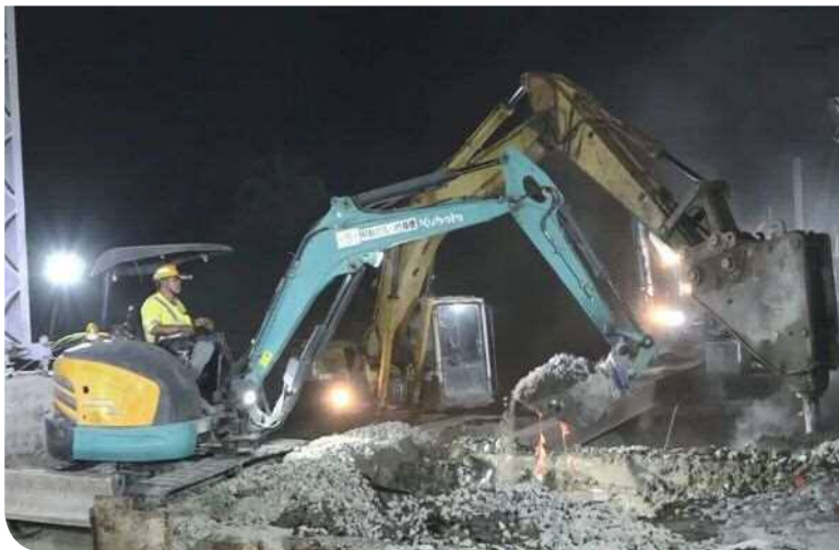
▲橋台結構物拆除作業
