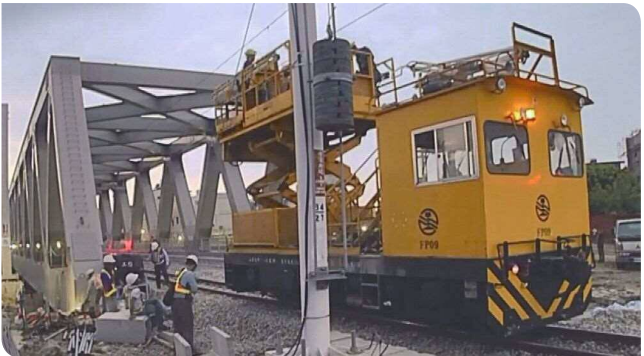
▲電車線架設施作
