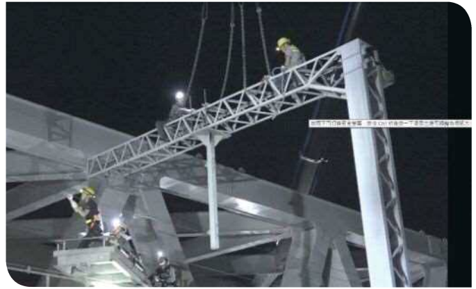
▲電車線拆除作業
