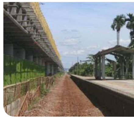
▲興建的高架與地面歸來車站
