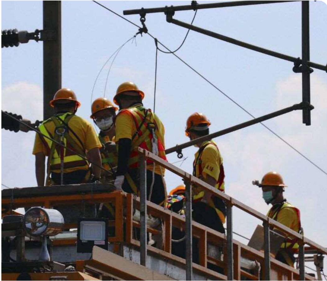
▲電車線搶修演練
