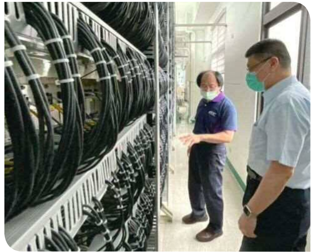
▲張簡嘉壬主任介紹繼電連鎖系統配線
