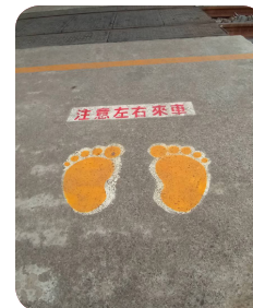
維修廠內軌道前劃設腳印提醒員工跨越軌道停看聽及指差確認。
