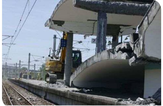
▲東里車站月台雨棚拆除作業
