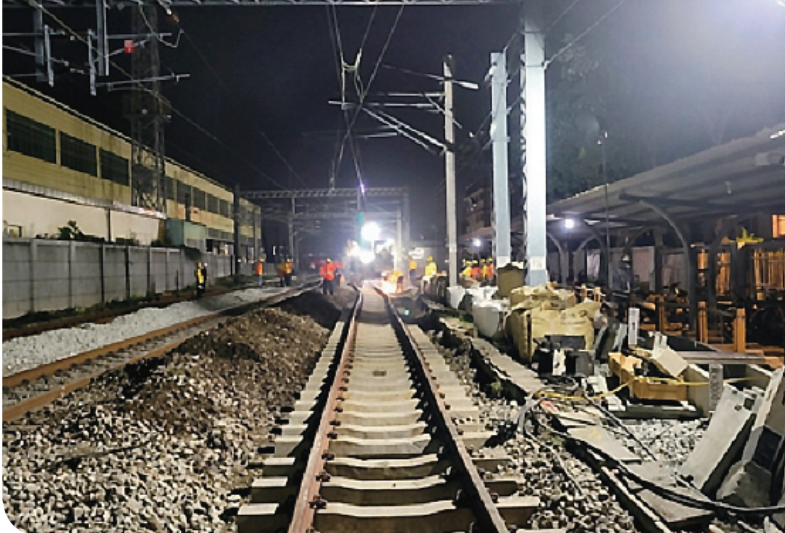
▲軌道切換路基移動作業
