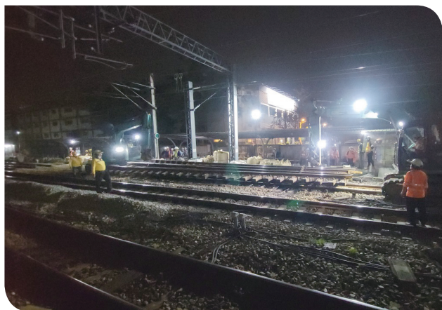
▲嘉義計畫第三工區第 2 次臨時軌切換 - 移除 102A 道岔
