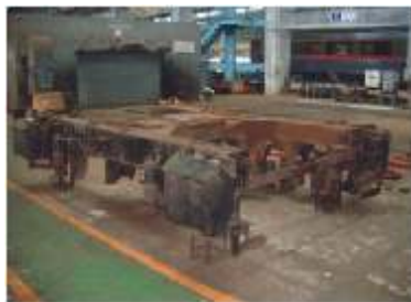
轉向架 (含逆轉機) 檢修
