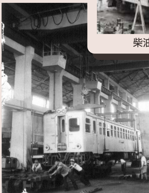
柴油客車進行拆車工作
