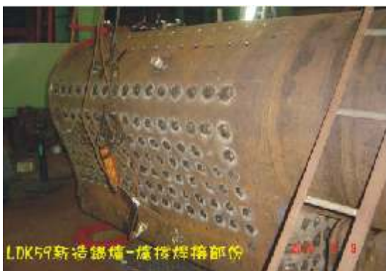
LDK59新造鍋爐－爐撐焊接部份
