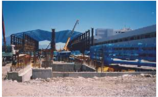
上圖為民國82年花蓮機廠修車工場開工興建中。
