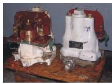
軔機及各閥類檢修
