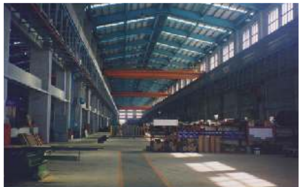
花蓮機廠修車工場興建完成之內觀。
