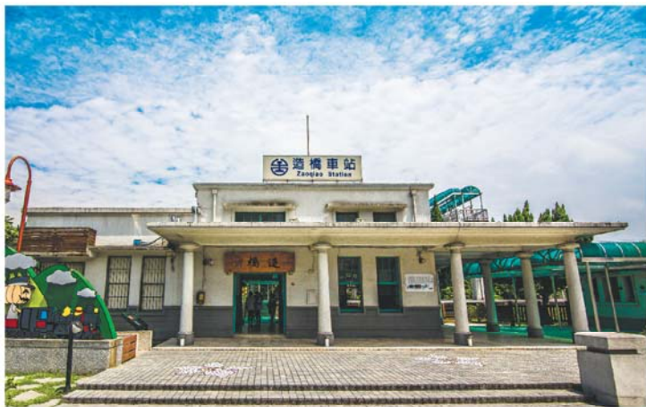
造橋車站以當年的先進技術鋼筋水泥建造而成。
