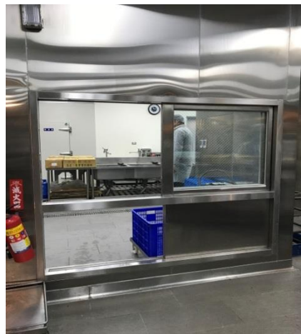
圖 17 前處理區烹調區傳遞口
