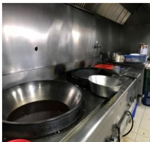
圖12花蓮餐務室烹調區(改善中)
