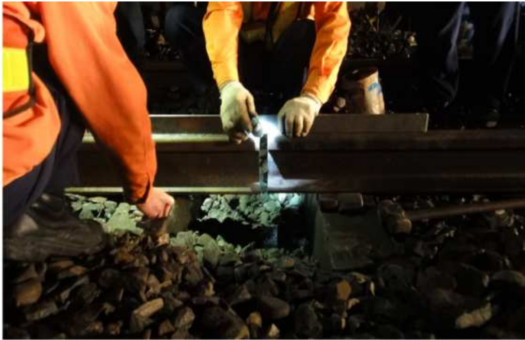
圖 4-9 焊接軌縫量測
