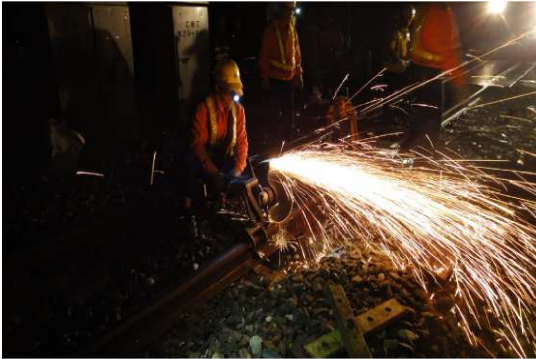
圖 4-7 鋼軌裁切作業
