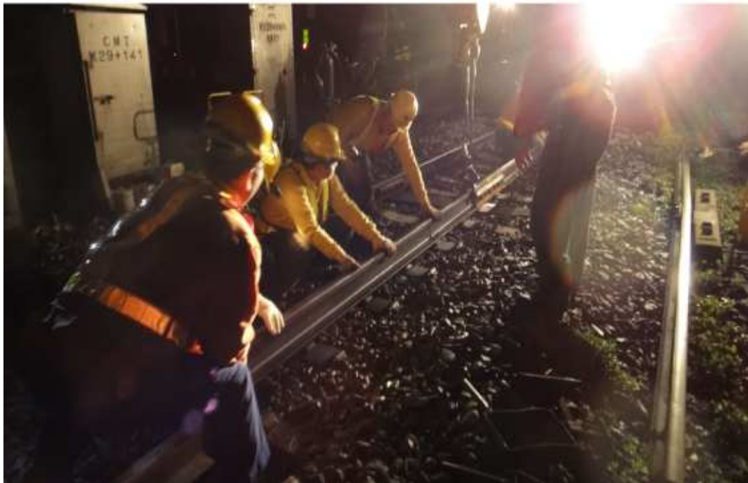
圖 4-8 新軌吊運作業
