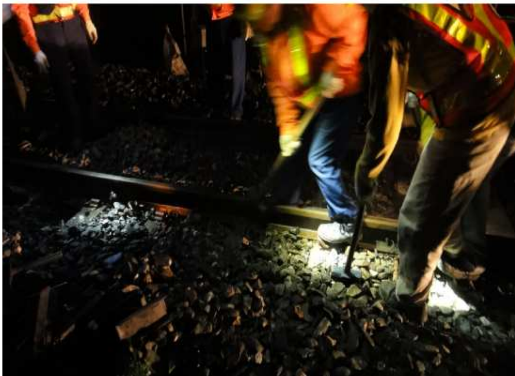
圖 4-6 扣件拆除作業
