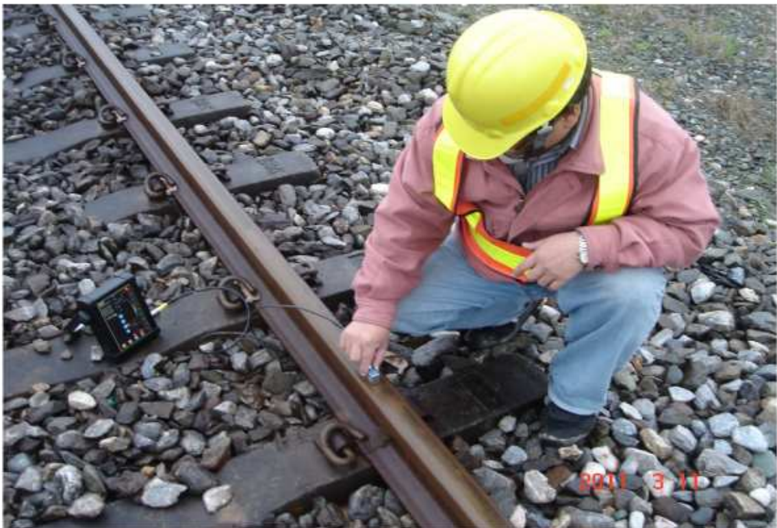
圖 5-10 現場焊道檢測
