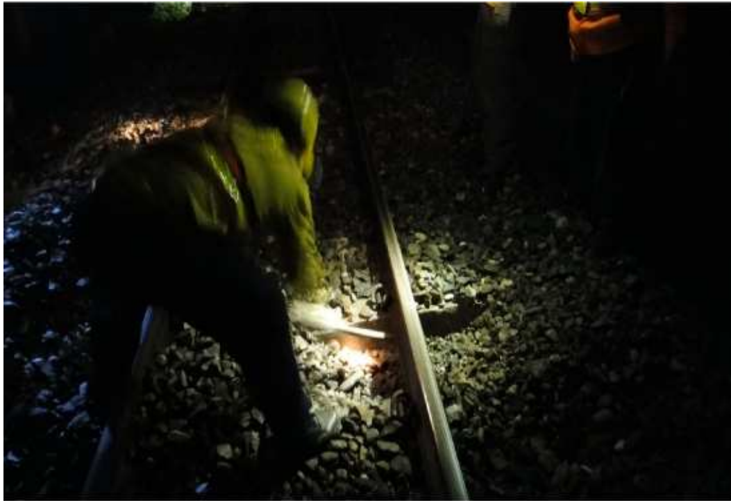
圖 4-5 道碴挖掘作業
