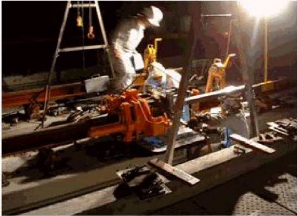
圖 4-1a 瓦斯壓接焊接法
