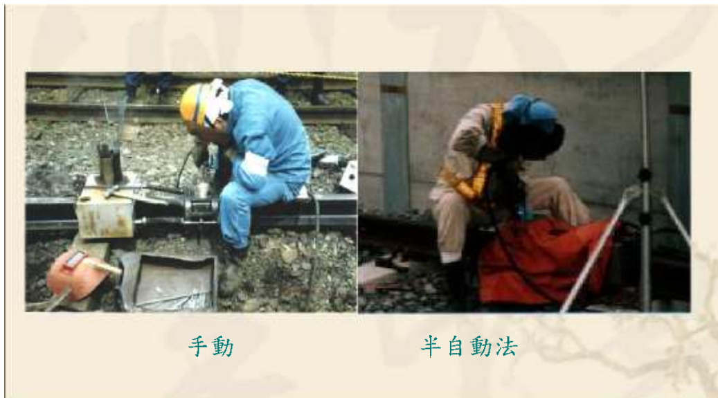
圖 4-3b 封閉式電弧焊法
