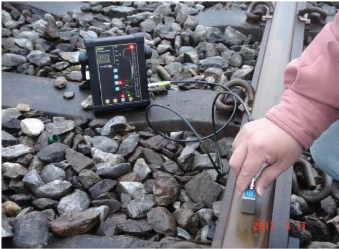
圖 5-11 現場焊道檢測
