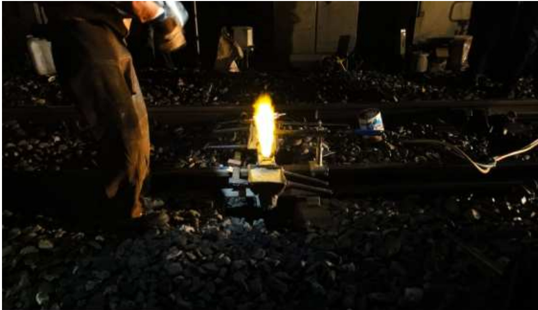
圖 4-4 熱劑焊接法接
