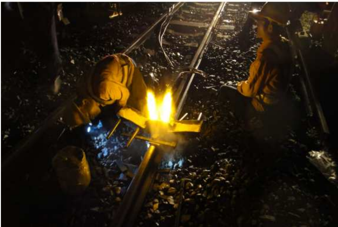
圖 4-12 預熱及防漏檢查
