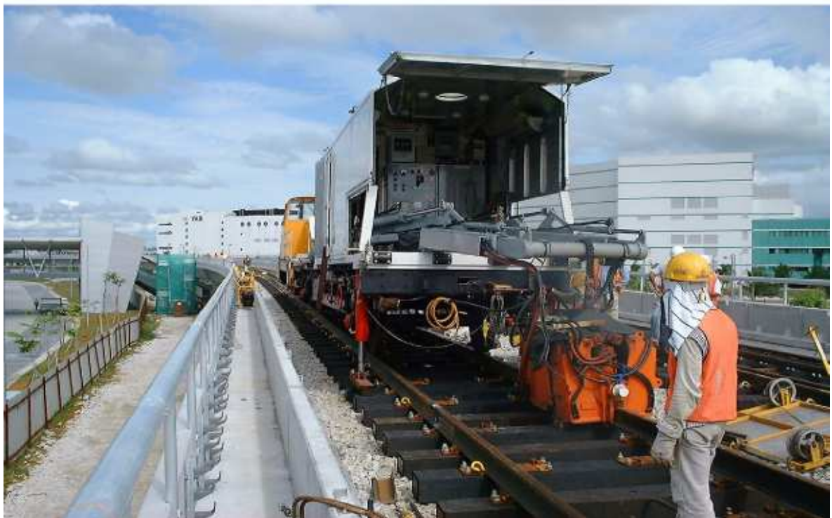
圖 4-2a 電阻火花焊接法
