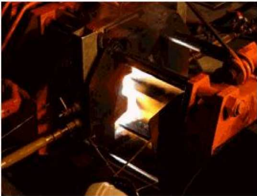
圖 4-1b 瓦斯壓接焊接作業
