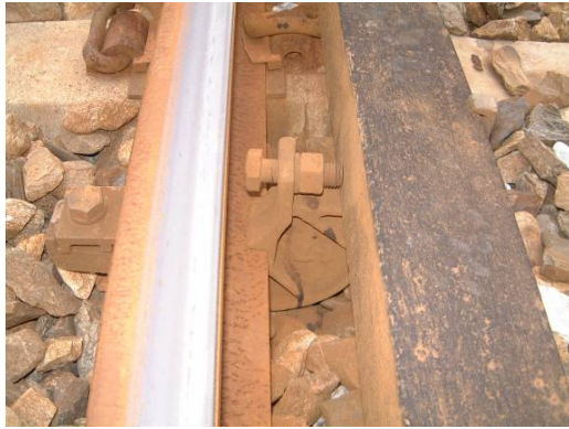
圖 7 防脫角鐵及托架圖，固定端採用壓板及螺栓鎖定於鋼軌底部趾端 防脫角鐵之裝設工作，如圖 8~11 所示，概述如下：
