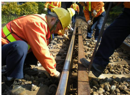
圖 9 防脫角鐵定位，托架組裝
