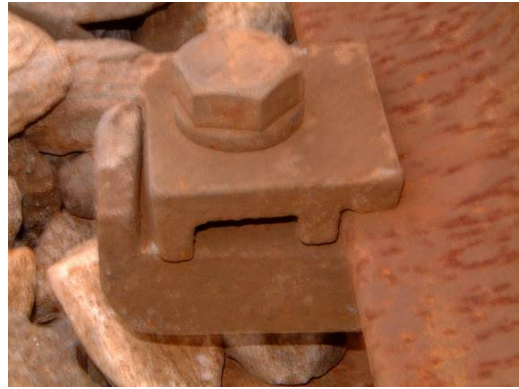
圖 7 防脫角鐵及托架圖，固定端採用壓板及螺栓鎖定於鋼軌底部趾端 防脫角鐵之裝設工作，如圖 8~11 所示，概述如下：
