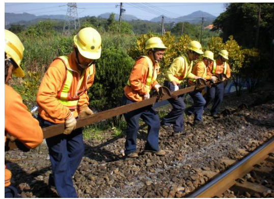
圖 8 軌道整理石碴整平，防脫角鐵移入
