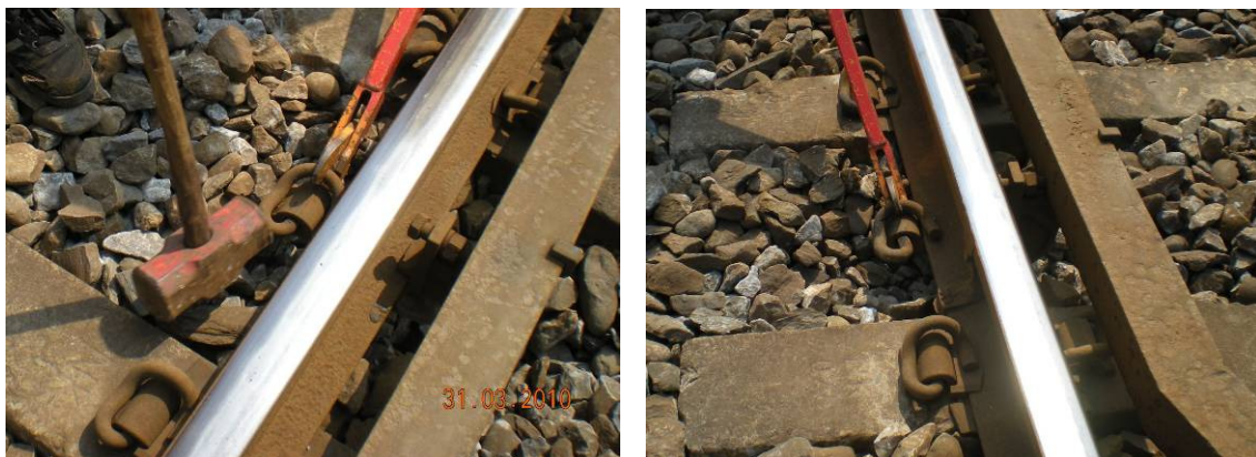
圖 14 扣夾型防脫角鐵托架：以扣夾固定
