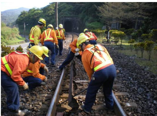
圖 9 防脫角鐵定位，托架組裝
