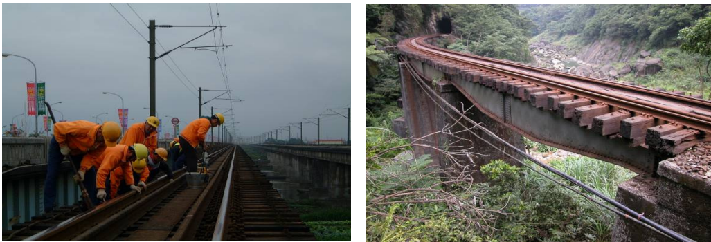
圖 4 橋上護軌照片（50 kg/m 鋼軌）
