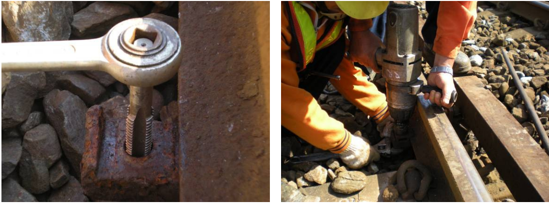
圖 10 托架螺牙洗孔，壓板螺栓鎖定
