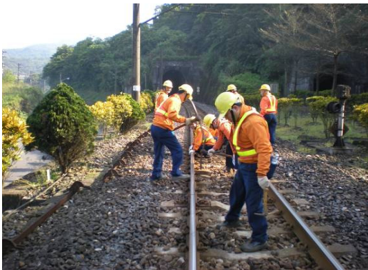
圖 8 軌道整理石碴整平，防脫角鐵移入
