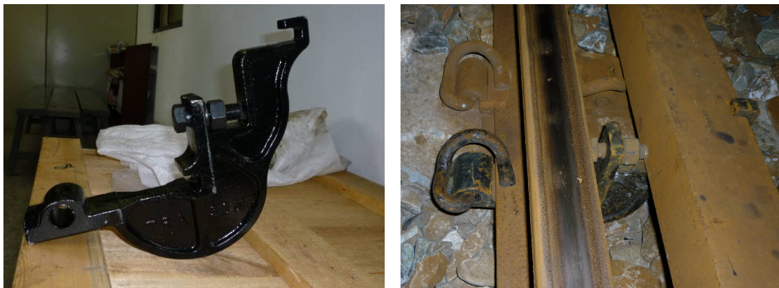
圖 13 扣夾型防脫角鐵托架
