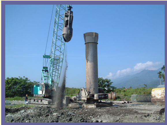
(1)全套管基樁施工
