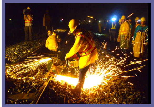
吉安~志學間曲線改善切換之鋼軌切除
