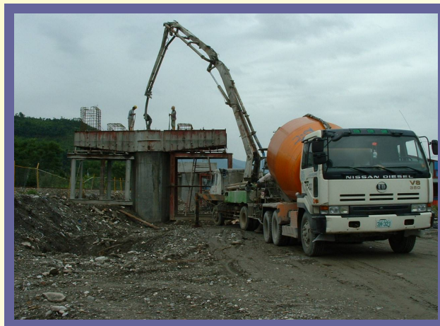
(3)帽樑澆置混凝土施工
