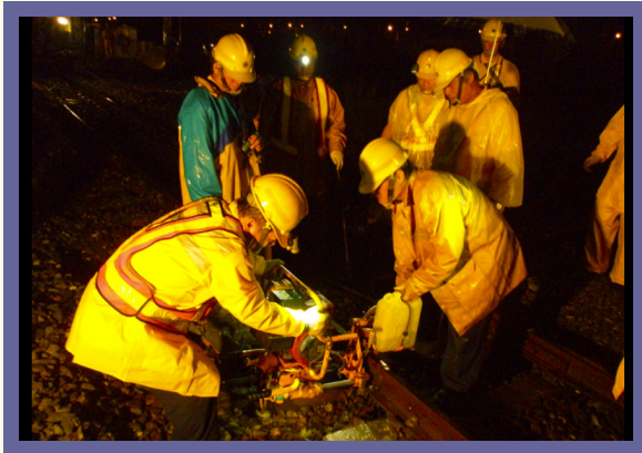
吉安~志學間曲線改善切換之鋼軌鑽孔
