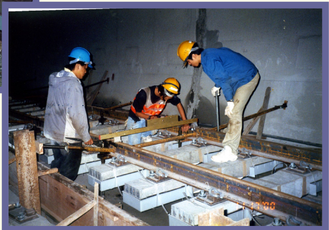
(4)平面性及軌距檢測調整
