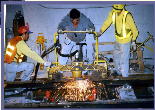
(6)鋼軌焊接（上部研磨）
