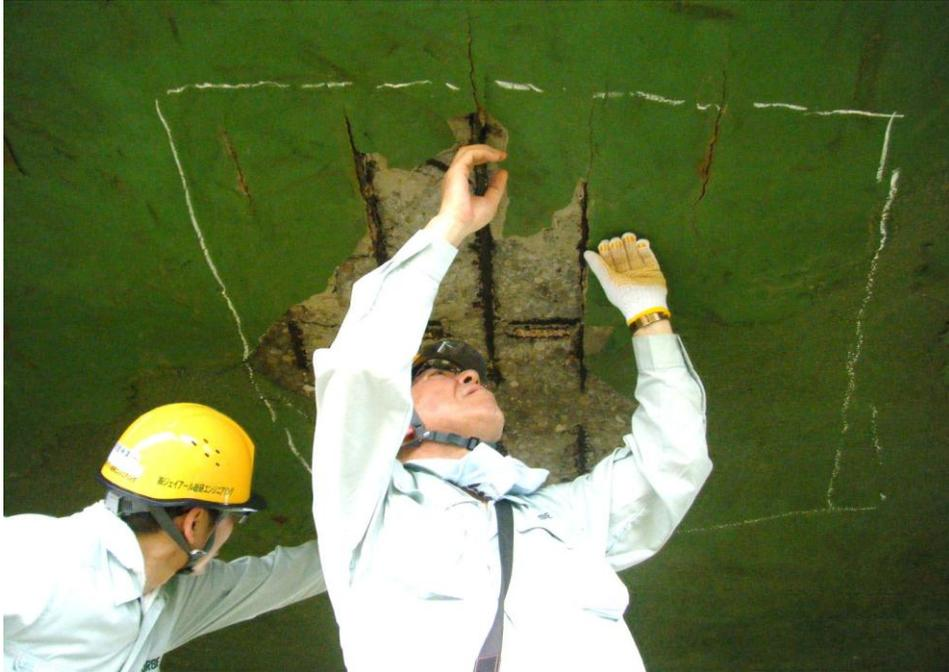
圖 19 確實執行鋼筋除鏽至表面未殘留鐵削
