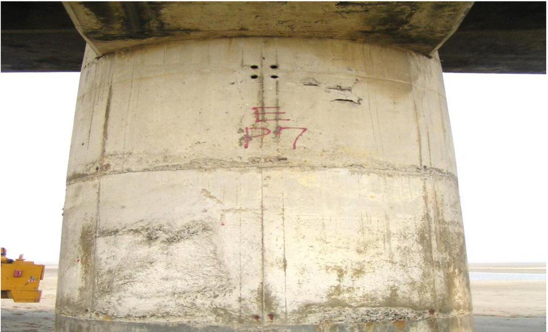
圖 7 92 年下三叉河橋 P7 橋墩混凝土剝落情形
