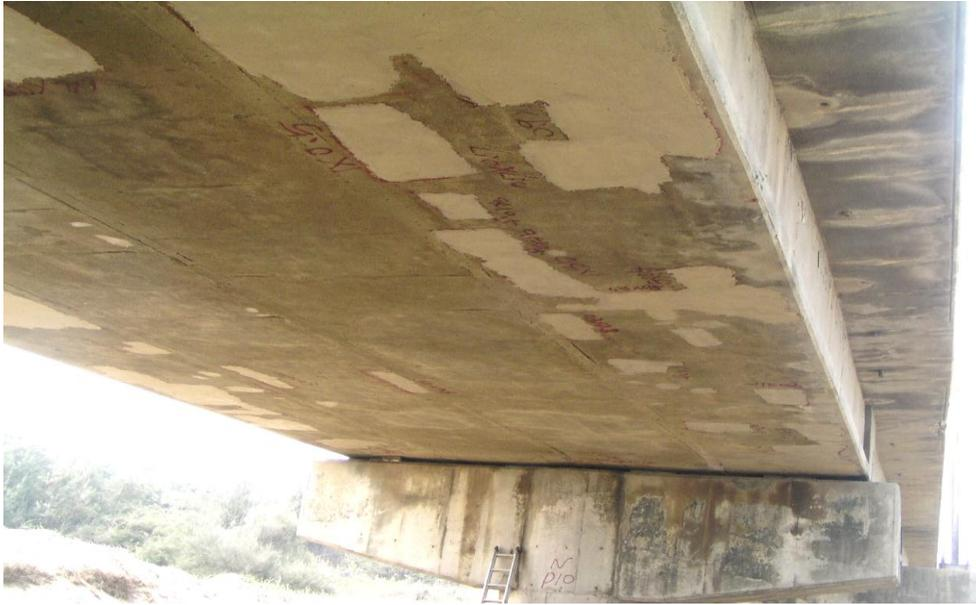
圖 9 92 年混凝土補修材修復完成
