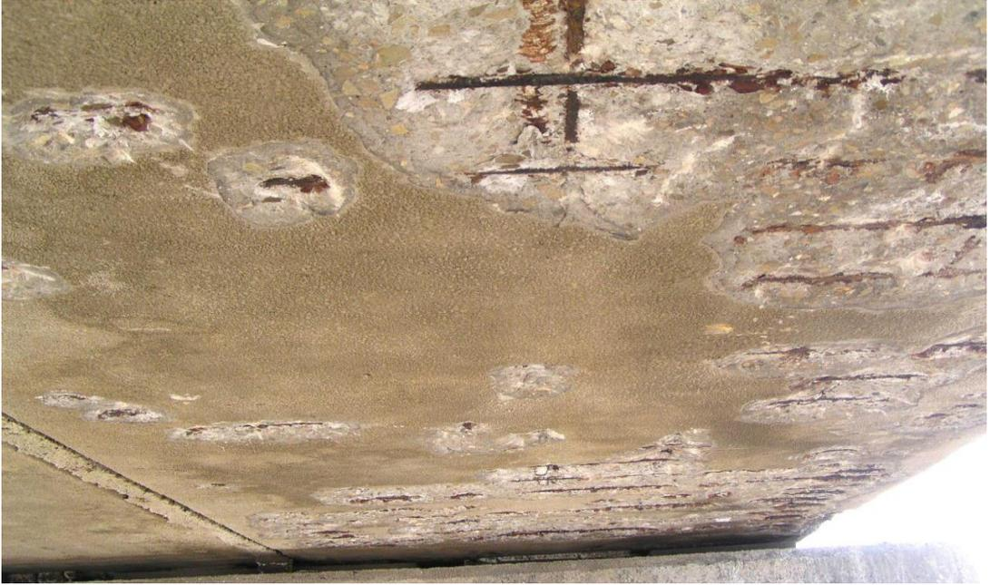
圖 6 92 年下三叉河橋橋底版混凝土剝落情形
