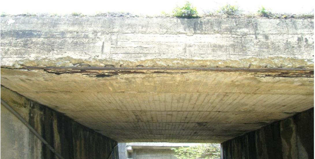
圖 1 海線橋梁受鹽害，導致混凝土剝落、鋼筋腐蝕之情形
