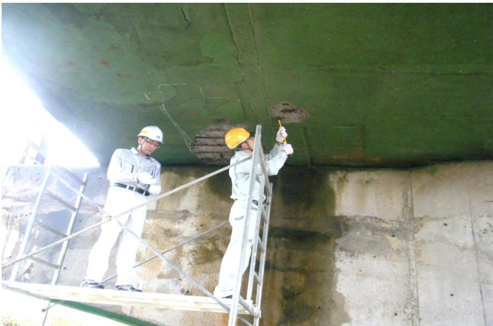
圖 18 將待補修面之混凝土鑿除至堅實面，下層鋼筋全斷面應露出
