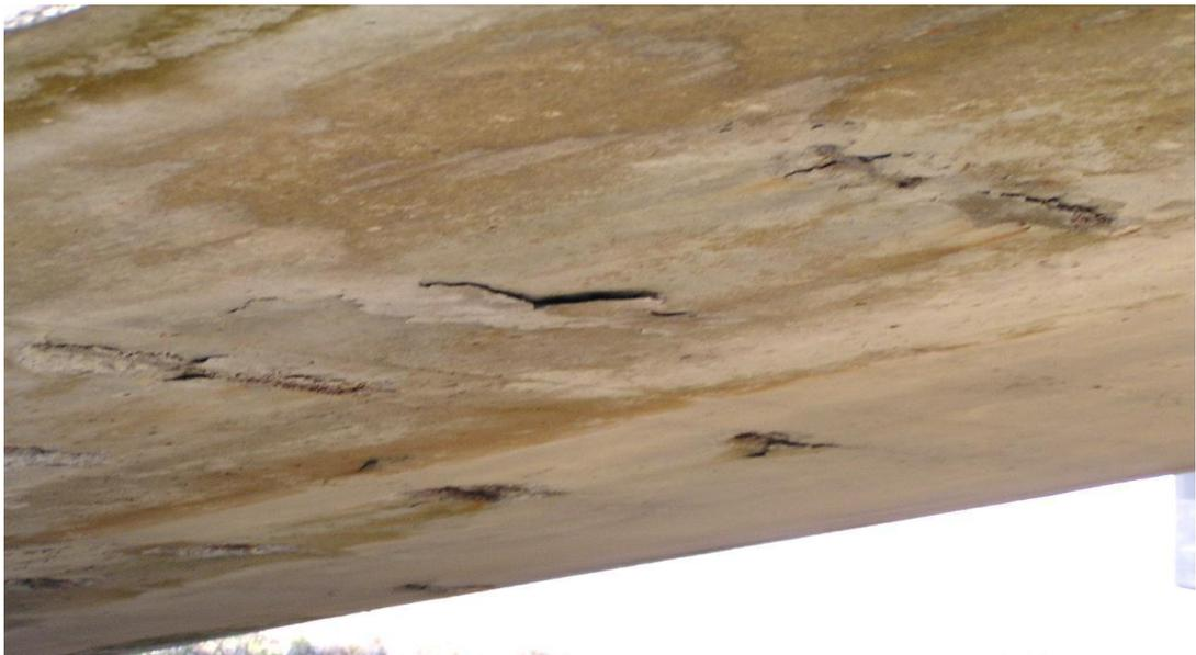
圖 2 鋼筋混凝土劣化過程加速期，產生混凝土裂縫及剝離之現象
