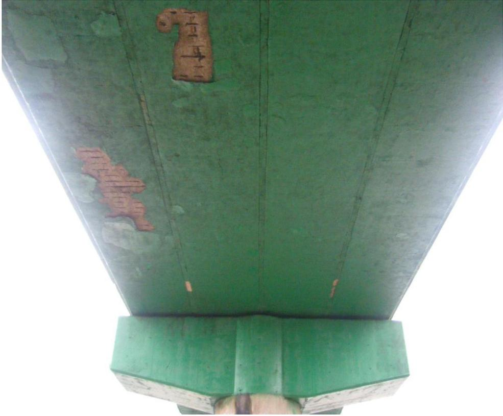
圖 13 傳統補修法氯離子包覆其中，仍會促成鋼筋腐蝕的條件，形成惡性循環
