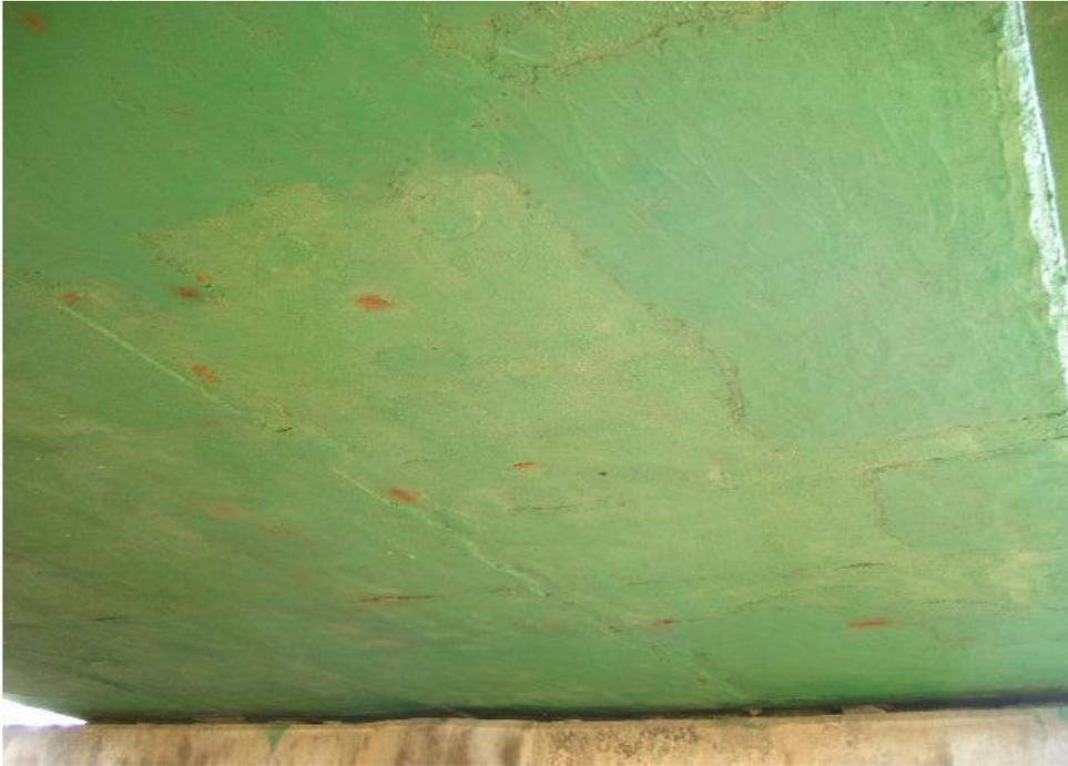
圖 11 96 年間勘查，補修後之橋底版明顯又滲出多處鏽痕
