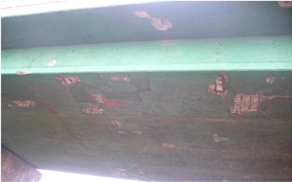
圖 12 98 年橋底版混凝土剝落現象持續發生
