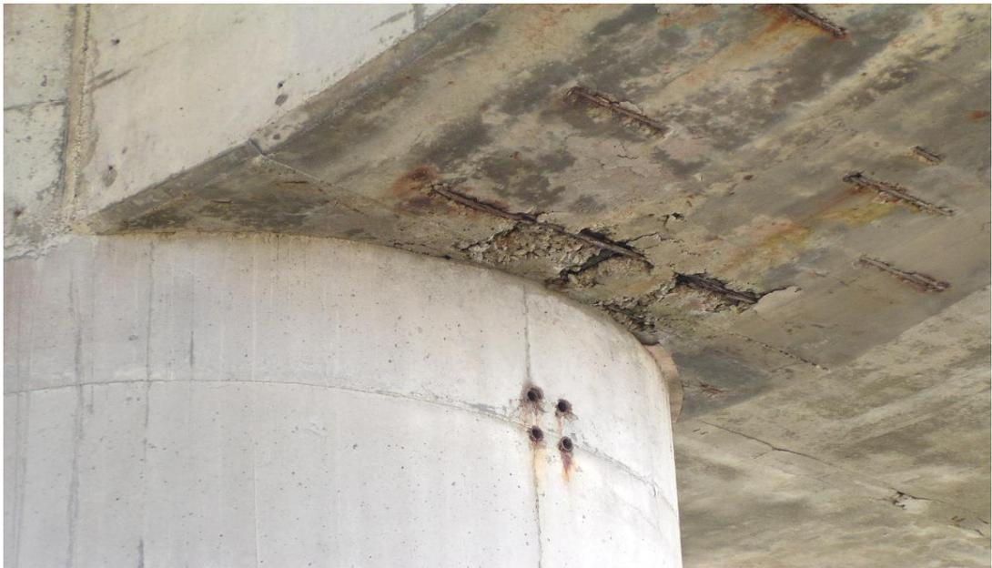
圖 5 92 年下三叉河橋帽梁底部混凝土剝落情形
