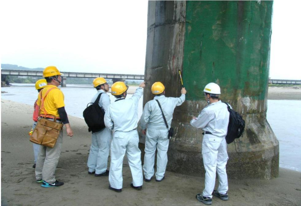
圖 17 敲擊混凝土表面由聲音判定結構密實狀況，作為待補修區域之判定
