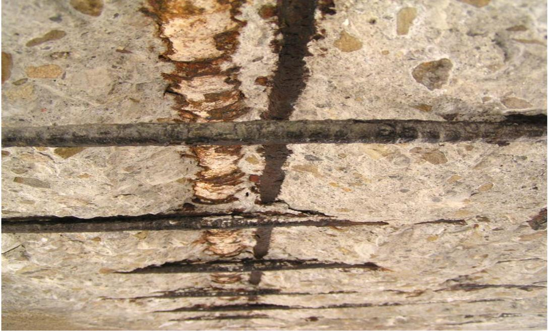
圖 3 混凝土保護層不足，鋼筋腐蝕後體積膨脹，將造成混凝土剝落
